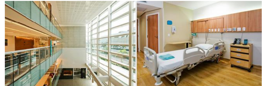
Figura 14 – Perfis metálicos (brises) que permitem a entrada de luz natural nos quartos e corredores do hospital.
