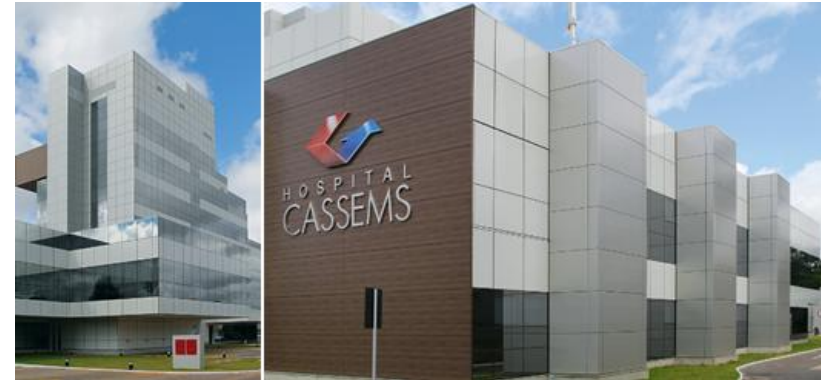
Figura 10 – Hospital CASSEMS, fechamento lateral com chapas de alumínio e pele de vidro.
