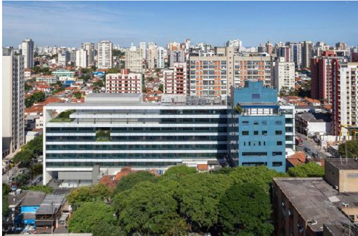
Figura 15 – Vista aérea da edificação.
