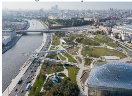
Figura 8: Vista da passarela.
