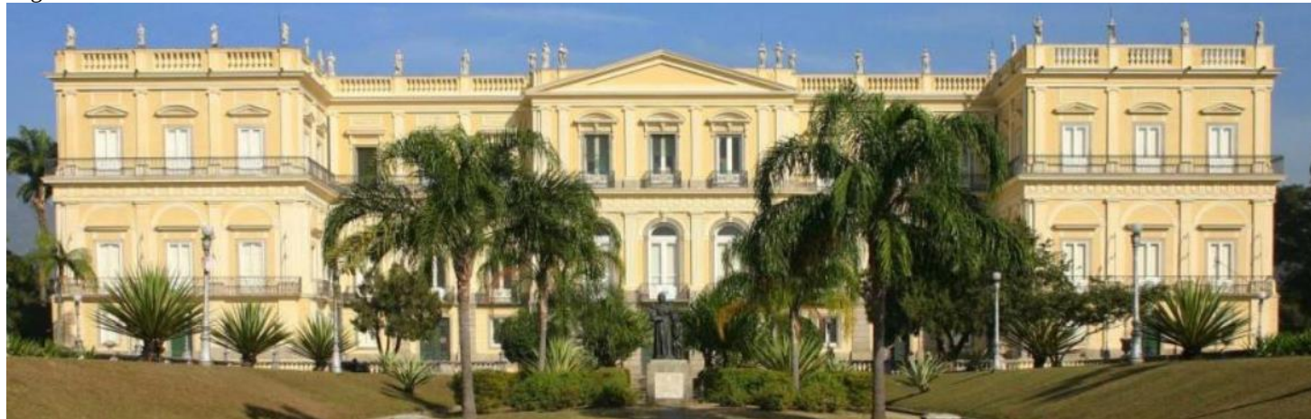
Figura 13 - Fachada Museu Nacional do Rio de Janeiro - Antes do incêndio.
