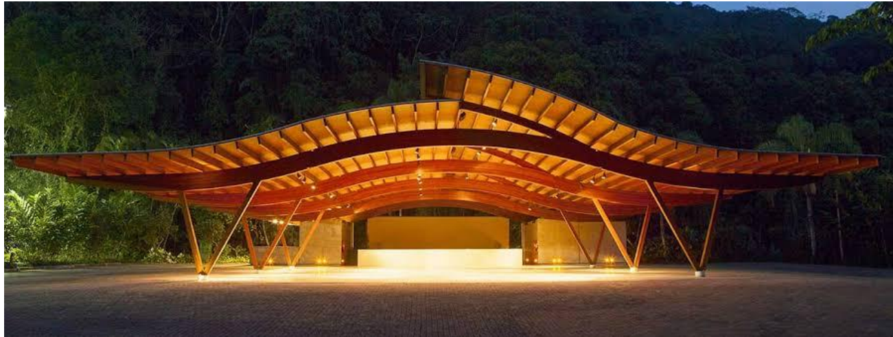
FIGURA 5: Cobertura construída com madeira laminada colada
