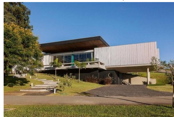
FIGURA 63: Residência em LSF, fase final
