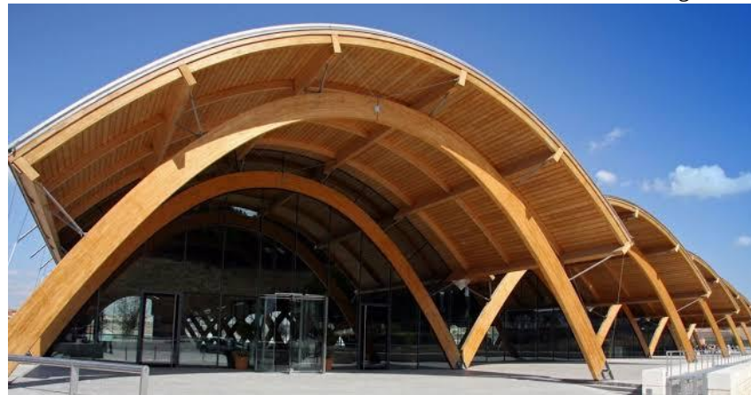
FIGURA 65: Cobertura de Madeira Laminada Colada, Galeria de Bodegas Protos
