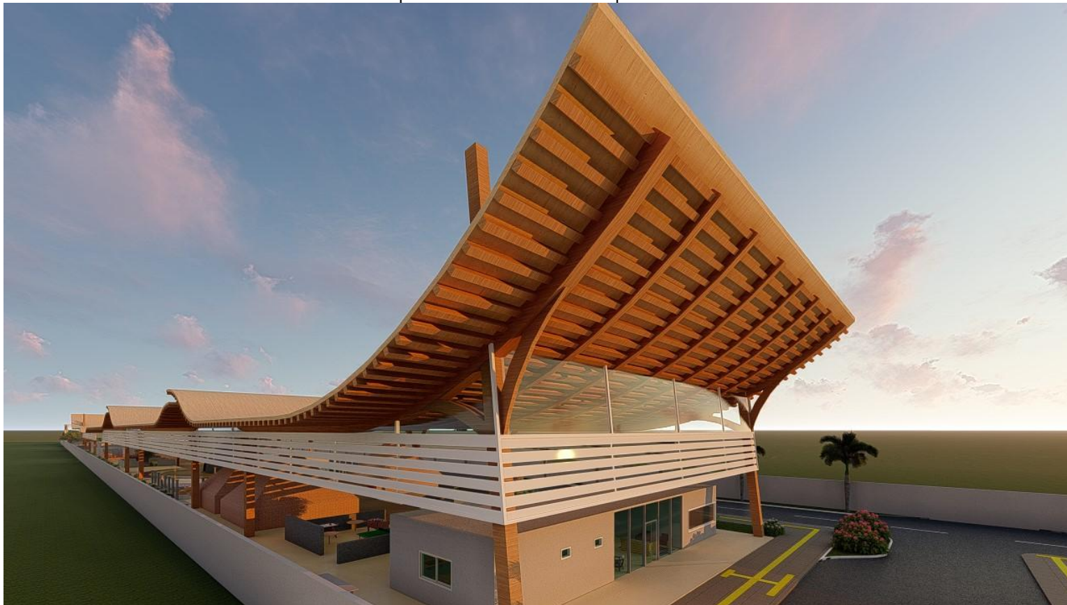
FIGURA 66: Vista da cobertura do empreendimento Green Garden para evidenciar o método construtivo com MLC
