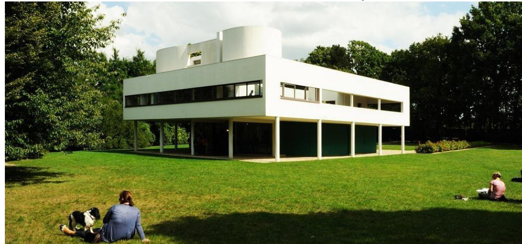
FIGURA 12: Vista externa Villa Savoye
