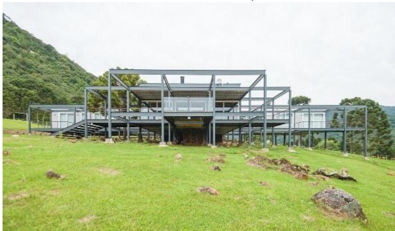
FIGURA 62: Residência em LSF, fase estrutural
