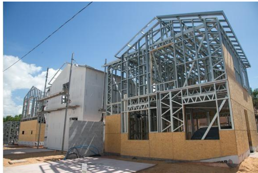
FIGURA 4: Método construtivo Steel Frame
