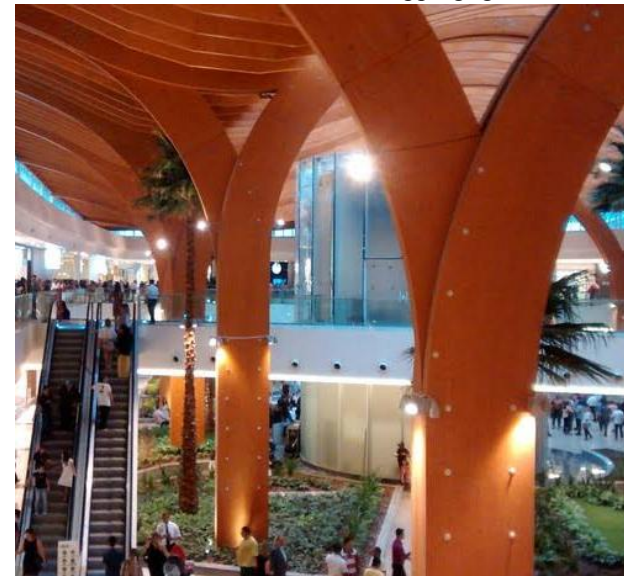
FIGURA 68: Pilar árvore estrutural, shopping Iguatemi Fortaleza
