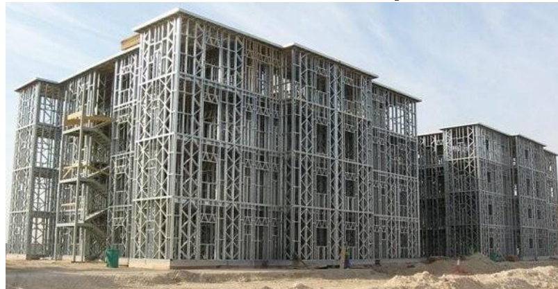
FIGURA 64: Estrutural em LSF com 4 pavimentos
