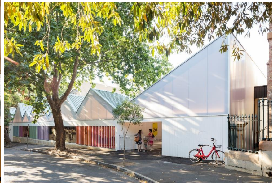
Figura 30: Fachada da edificação
