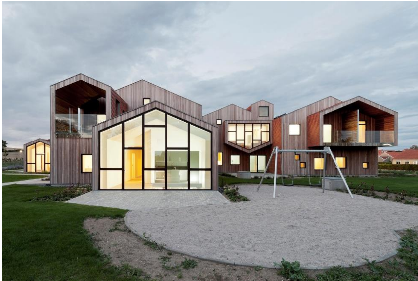
Figura 31: Fachada frontal da Edificação.
