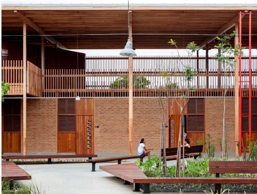
Figura 19: Pátios Externo da edificação
