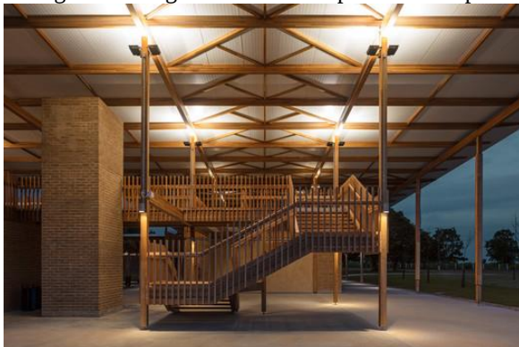
Figura 7- Imagem de acesso ao pavimento superior.
