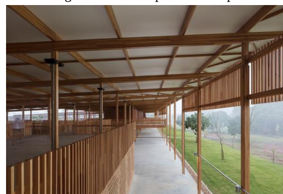
Figura 8- Vista do pavimento superior.
