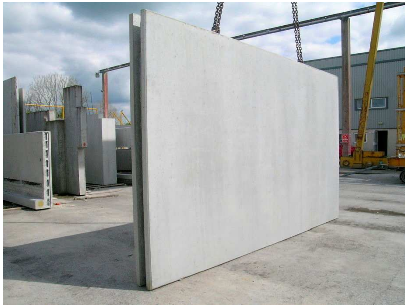
Figura 52 – Parede dupla pré-fabricada
