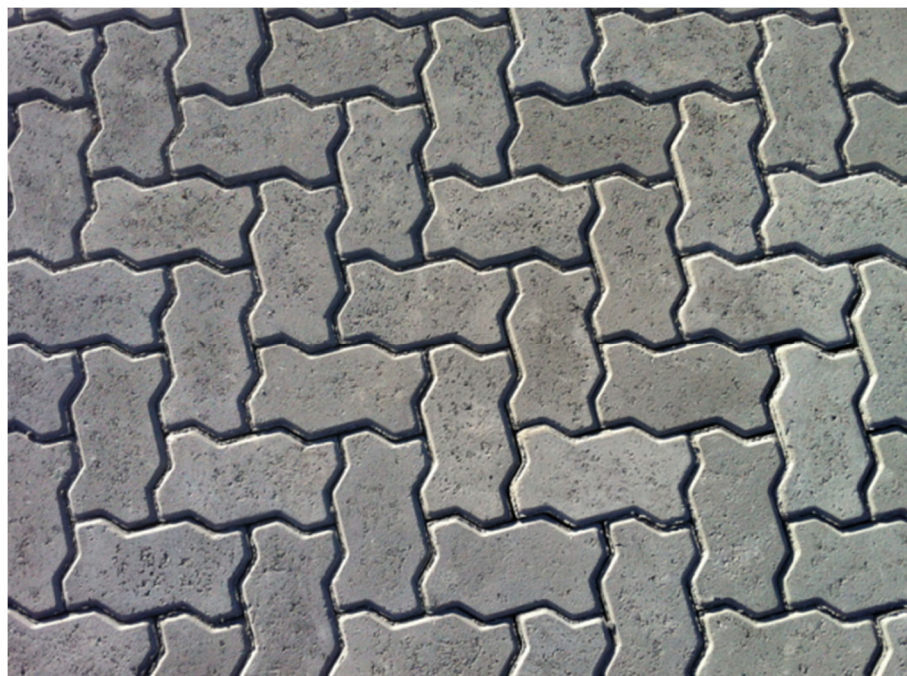
Figura 50: Piso intertravado
