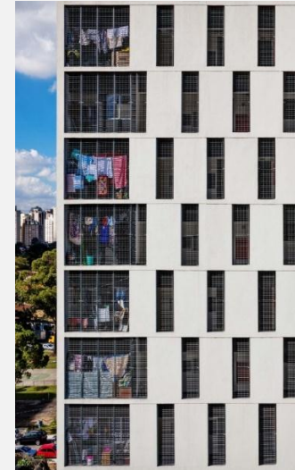
Figura 13 – Fachada das Unidades Habitacionais do Conjunto Habitacional do Jardim Elite.
