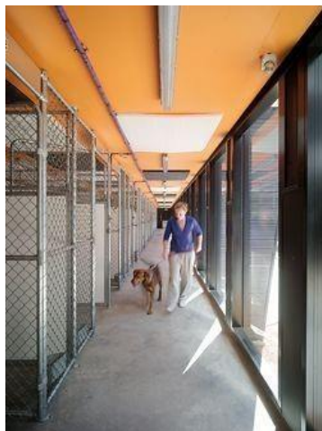
Figura 14: Fotografia do corredor das alas do canil.
