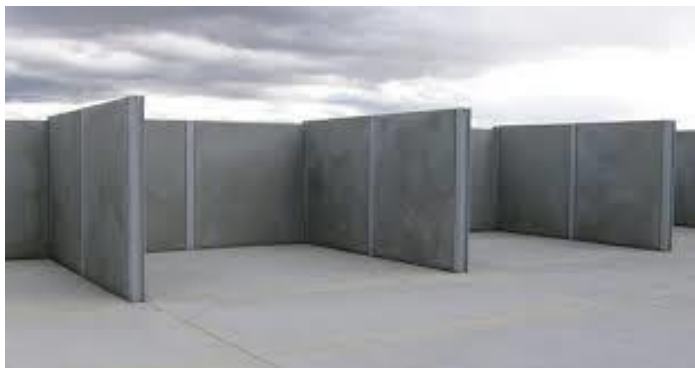
Figura 55: Estrutura da parede pré-moldado.
