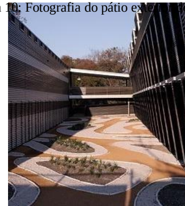
Figura 10: Fotografia do pátio exterior do edifício-canil.
