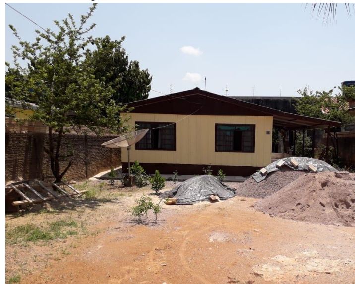
Figura 65 - Casa Colidense de madeira.
