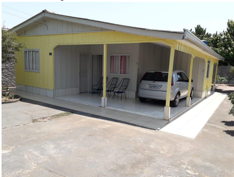
Figura 64 - Casa Colidense de madeira.
