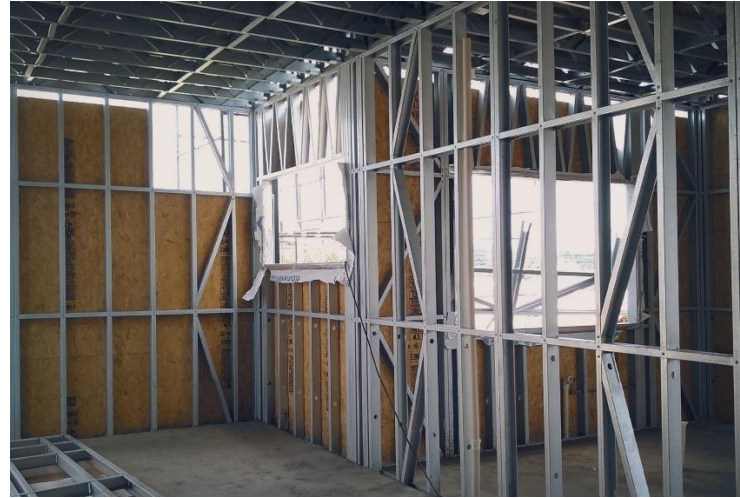
Figura 68 - Parede de vedação Steel Frame.
