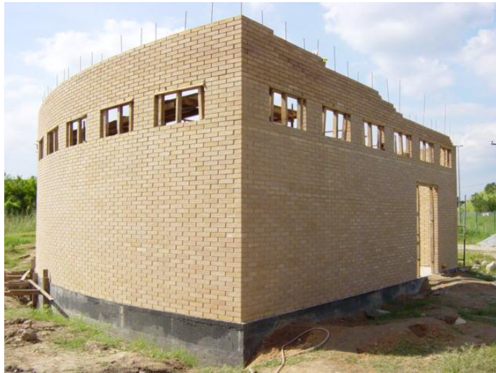
Figura 66 - Construção com Parede Curva.
