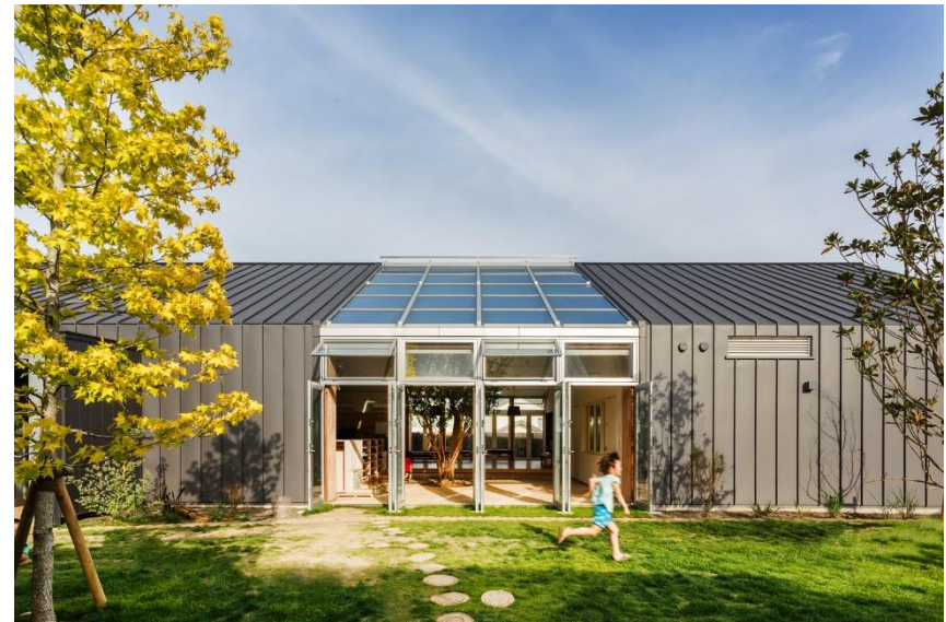
Figura 36 - Outra lateral de área de convívio externo da Creche HN.
