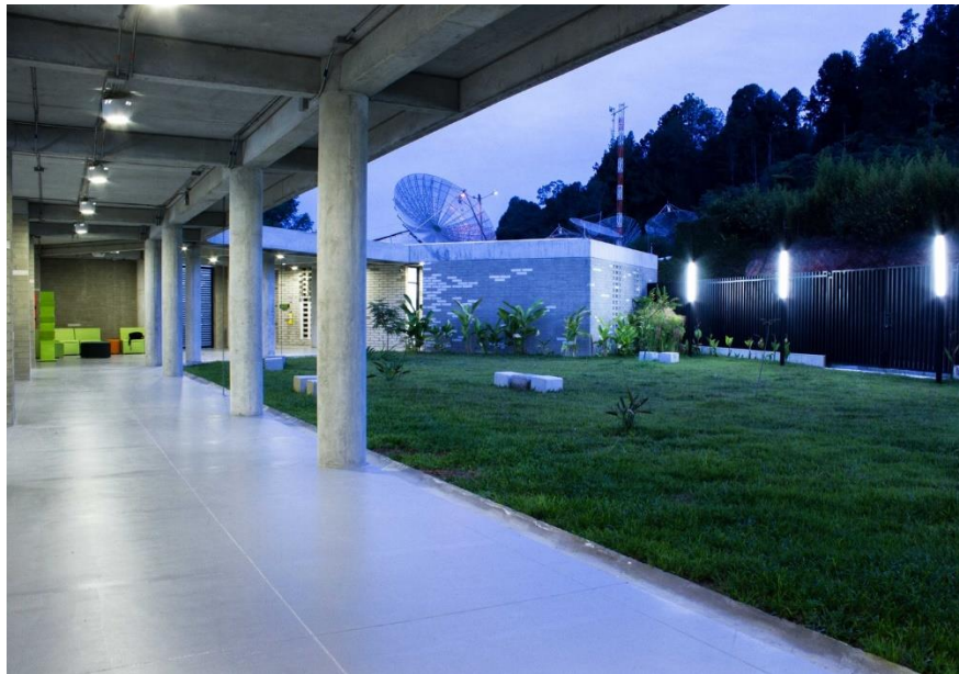
Figura 26 - Extensão da circulação ladeada por Pátios Jardim.
