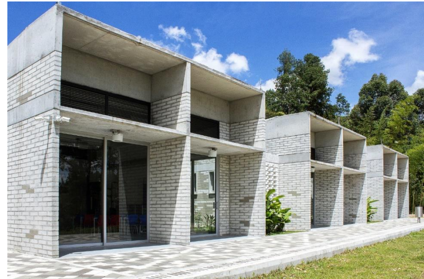
Figura 19 - Fachadas em módulos de concreto e vidro.
