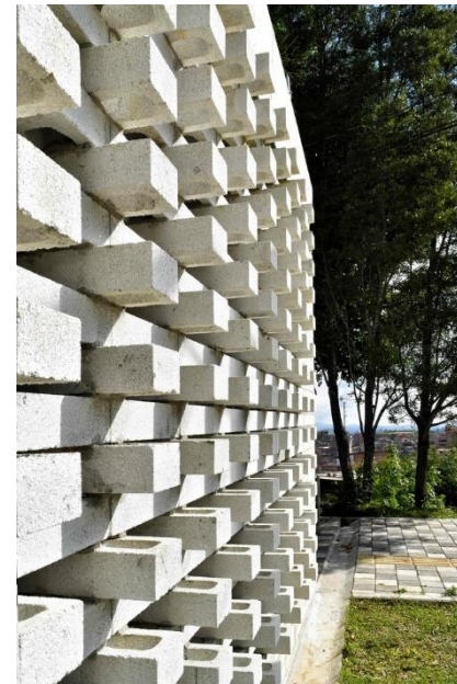
Figura 29 - Detalhe de encaixe dos blocos para circulação de ar.
