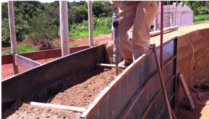
Figura 3 - Execução da Taipa
