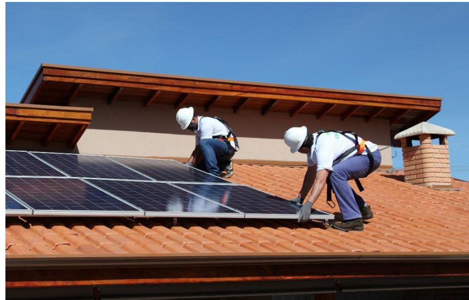
Figura 11 - Instalação de Placa fotovoltaica
