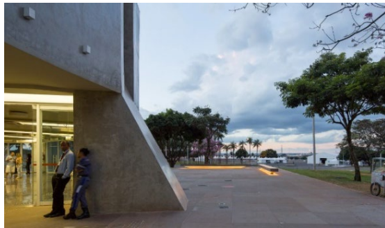
Figura 39: Entrada Principal da Edificação
