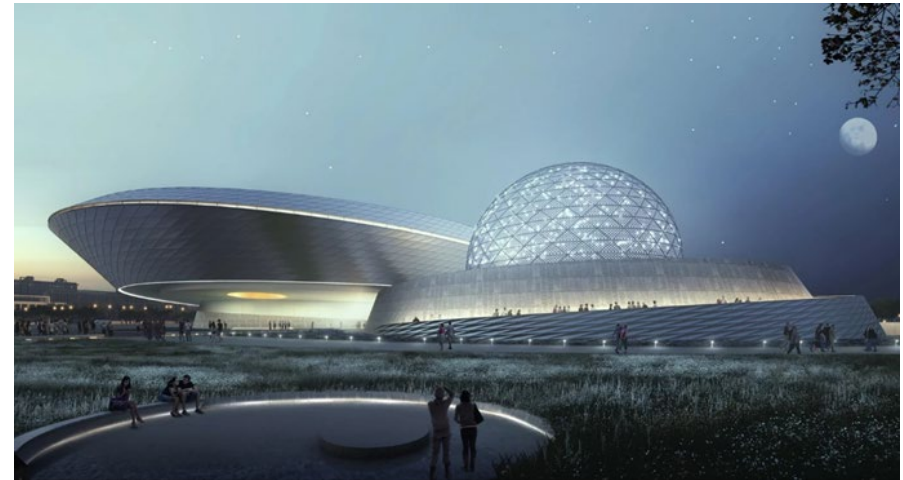
Figura 24: Entrada Principal da Edificação - Oculus
