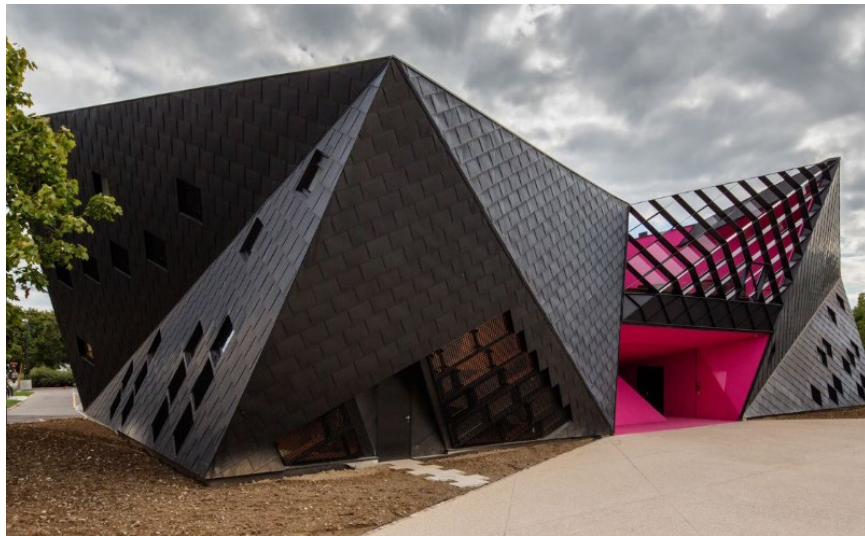
Figura 42: Vista Fachada Lateral
