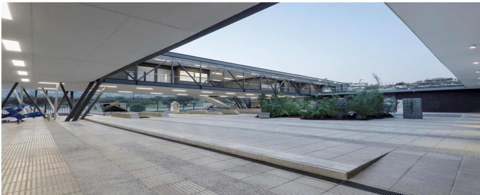
Figura 9: Vista pátio central
