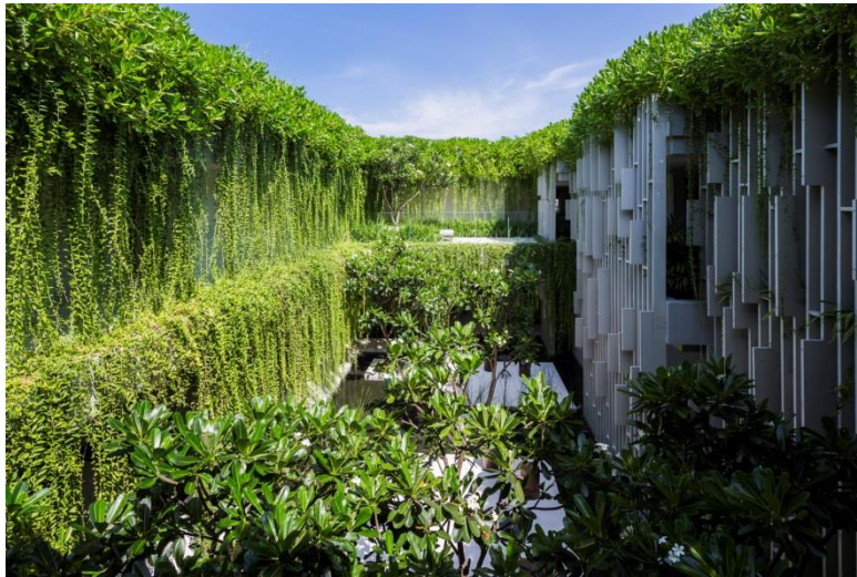
Figura 17: Vista do pátio interno
