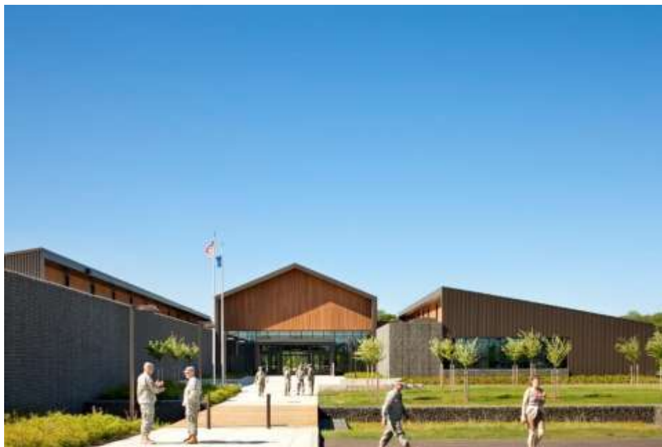
Figura 7 - Fachada principal do Centro de Preparação Coronel Nesmith
