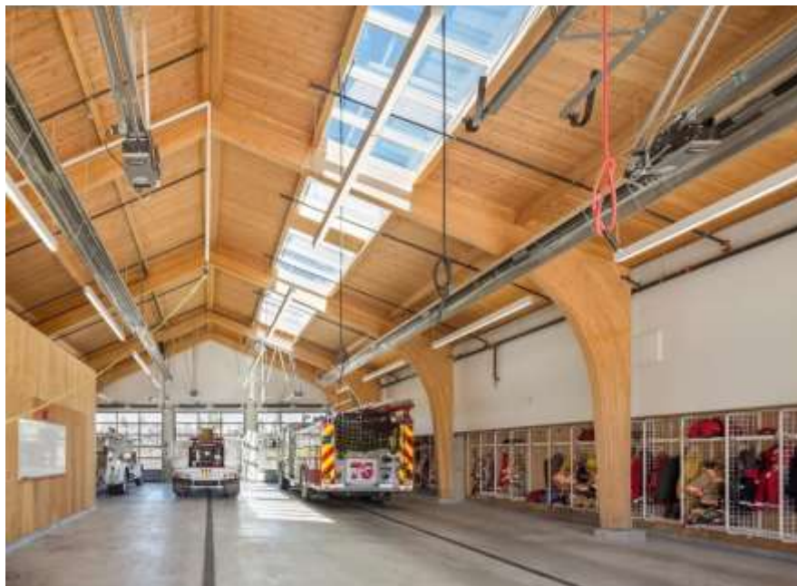
Figura 9 – Área destinada aos veículos da Estação de Bombeiros 79.
