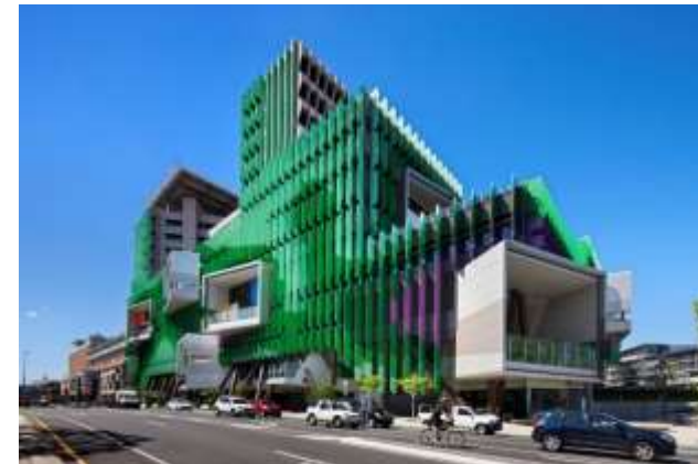
Figura 59- Fachada Hospital Lady Cilento.
