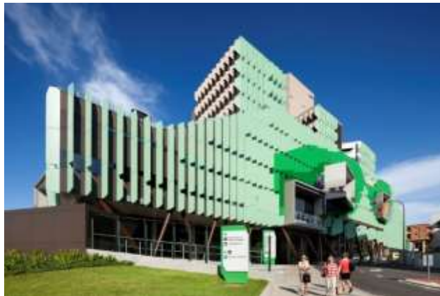
Figura 58- Fachada Hospital Lady Cilento.
