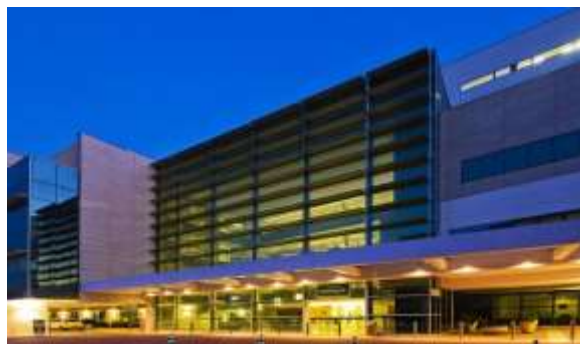
Figura 29 – Fachada composta de vidro e brise.
