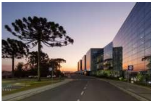
Figura 45 – Acesso de veículos e pedestres.
