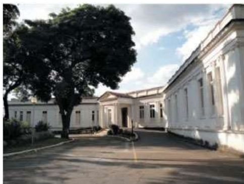
Figura 9 – Fachada principal do Hospital Borges da Costa
