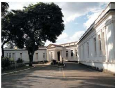
Figura 5 – Fachada Hospital Borges da Costa
