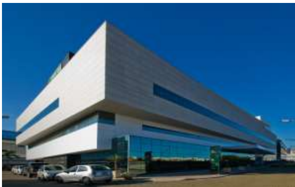
Figura 32 – Bloco 1, de alta complexidade.
