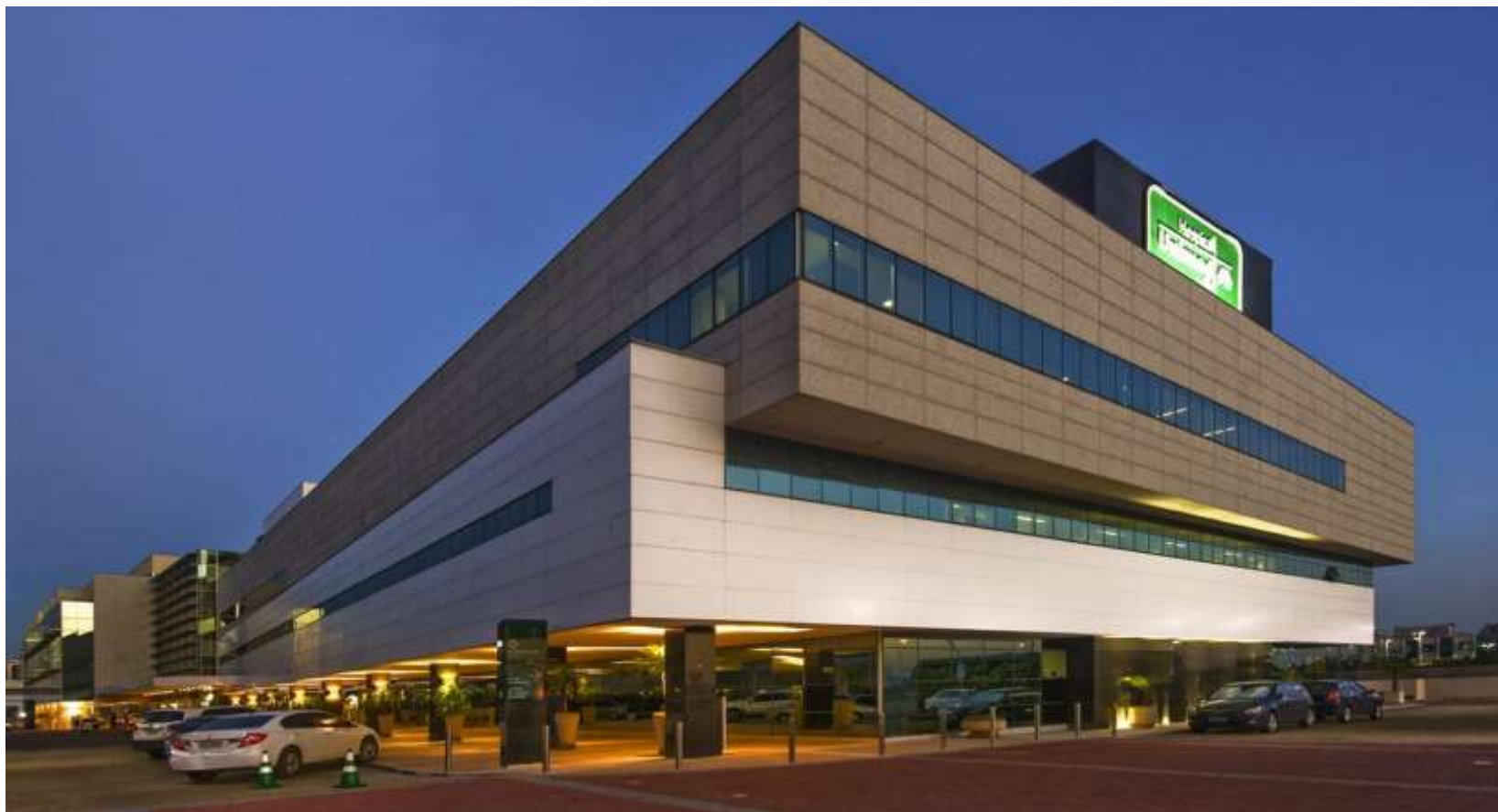
Figura 44 – Hospital Unimed Rio.
