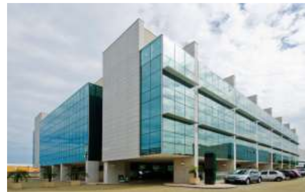
Figura 33 – Bloco 2, de internação.
