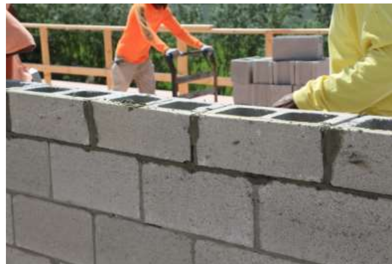
Figura 86 – Parede com bloco de concreto.
