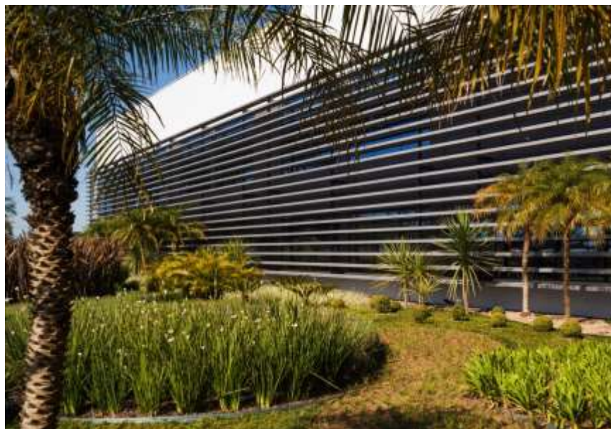
Figura 51 – Sistema de brises nos quartos.
