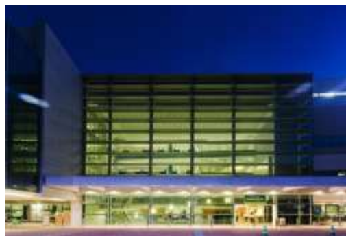
Figura 30 – Entrada recepção principal.
