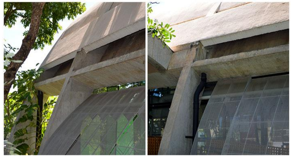
Figura 66: Captação de Água -CSS
