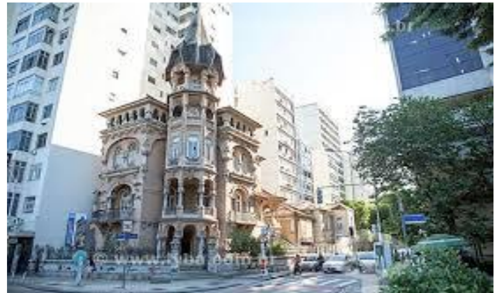
Figura 4: Fachada Castelinho do Flamengo
