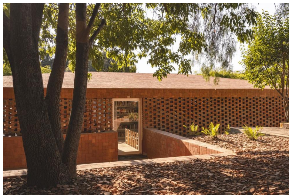
Figura 56: Fachada Posterior - Centro Cultural Morelia
