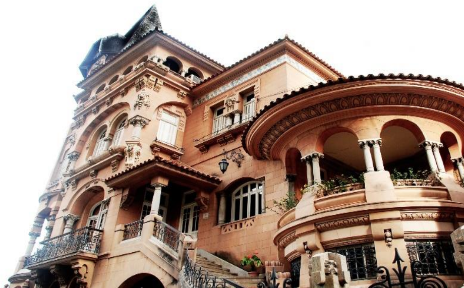
Figura 3: Fachada Castelinho do Flamengo
