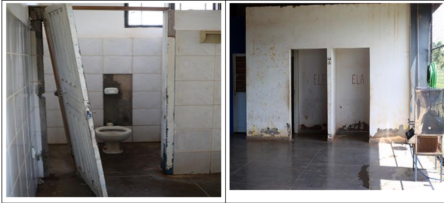
Figura 22: Sanitários do terminal de ônibus
