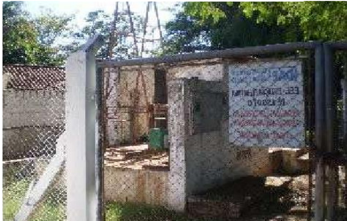
Figura 55: Estação elevatória de esgoto - Barra do Bugres
