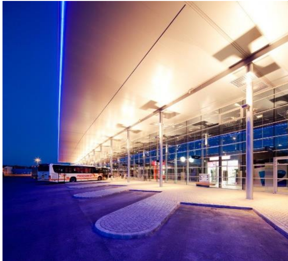
Figura 41: Vista das baias para embarques
