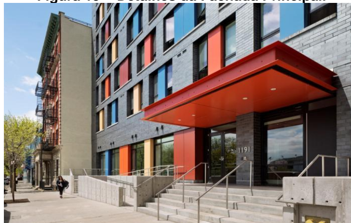
Figura 19 - Detalhes da Fachada Principal.
