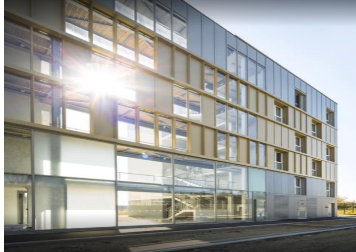
Figura 08 - Detalhes da fachada principal envidraçada.
