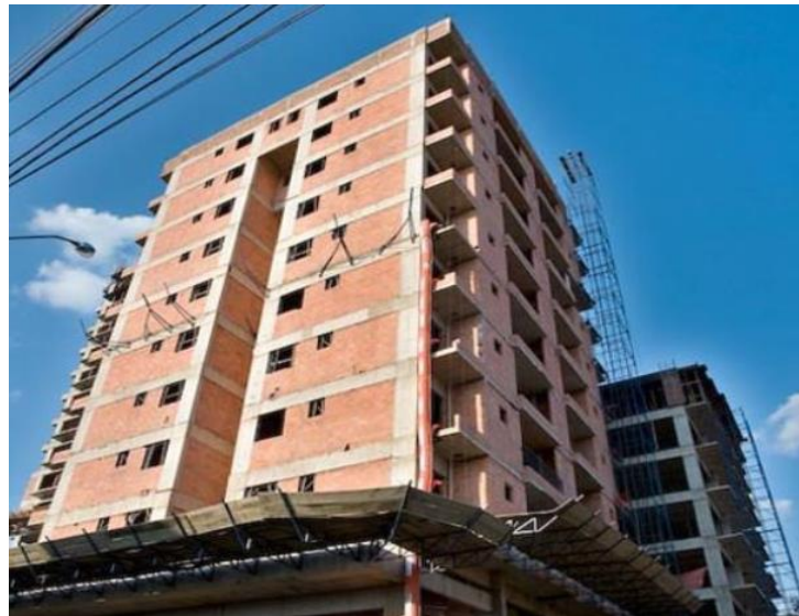
Figura 42: Prédio em alvenaria convencional
