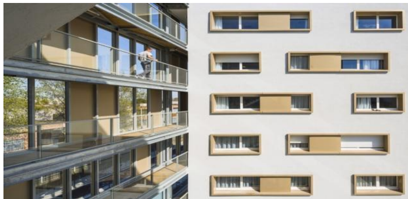
Figura 11 - Corredor que associa os dois blocos.
