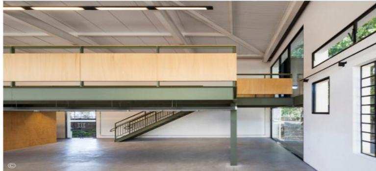
Figura 30 - Mezanino em aço dentro do edifício do Bloco C
