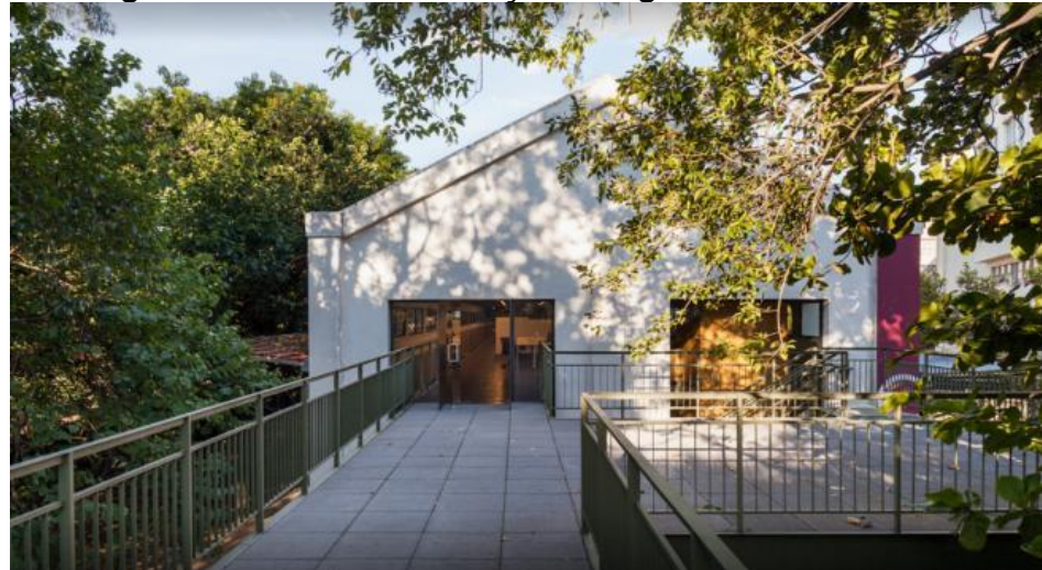
Figura 31 - Mezanino em aço interligando os dois edifícios
