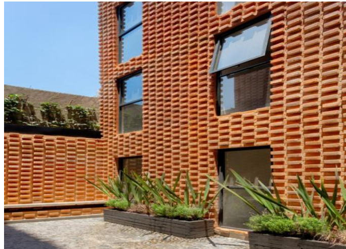
Figura 16 - Detalhe da alvenaria da fachada feita em barro vermelho recozido.
