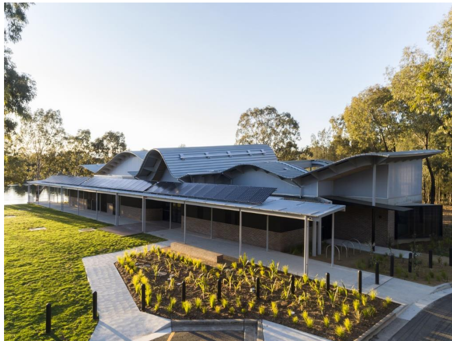
Figura 08 – Cobertura externa com placas fotovoltaicas.
