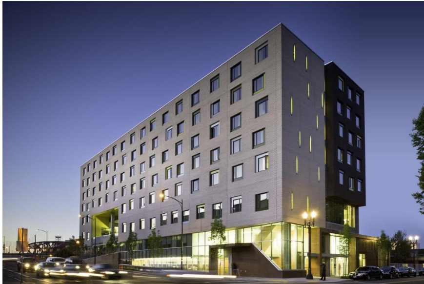
Figura 09 – Fachada frontal, ao Oeste
