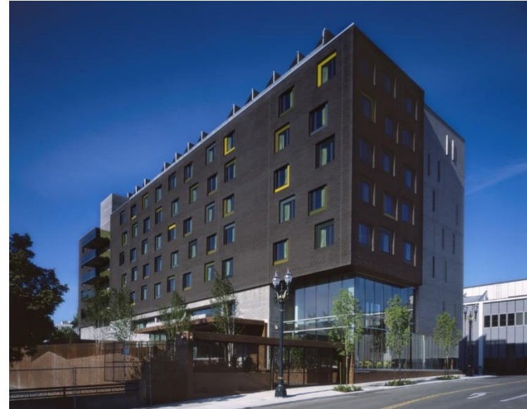
Figura 10 – Fachada frontal, ao Leste
