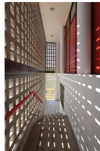
Figura 25 – Interior/corredor com cobogós
