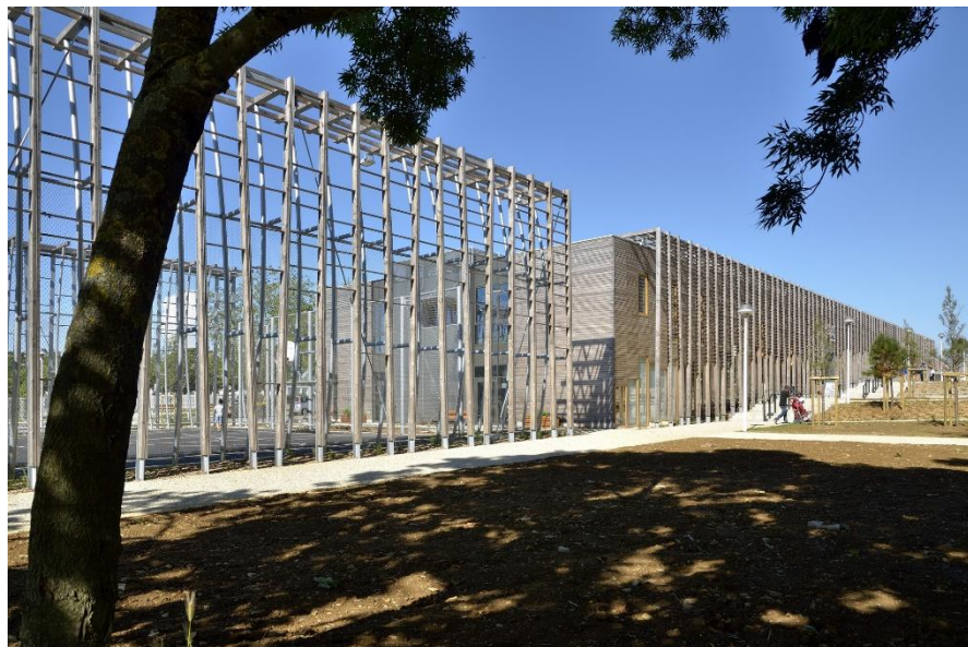
Figura 20 – Fachada em construção
