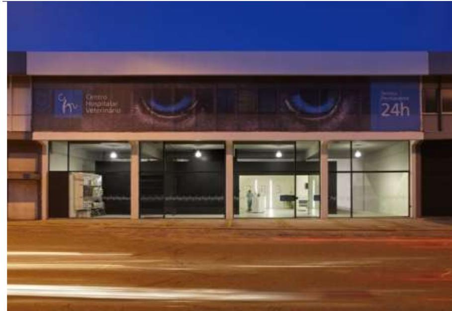
Figura 53 – Fachada do Hospital Veterinária CHV
