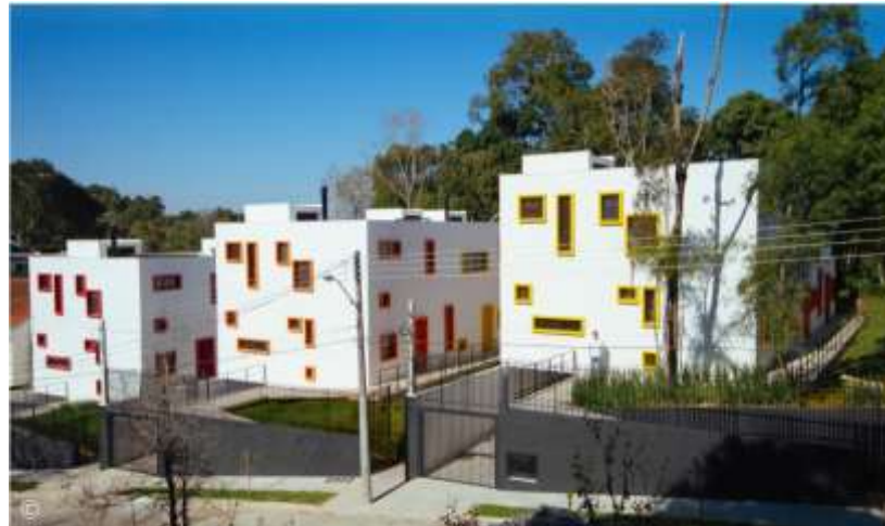
Figura 56 – Fachada das casas cubo
