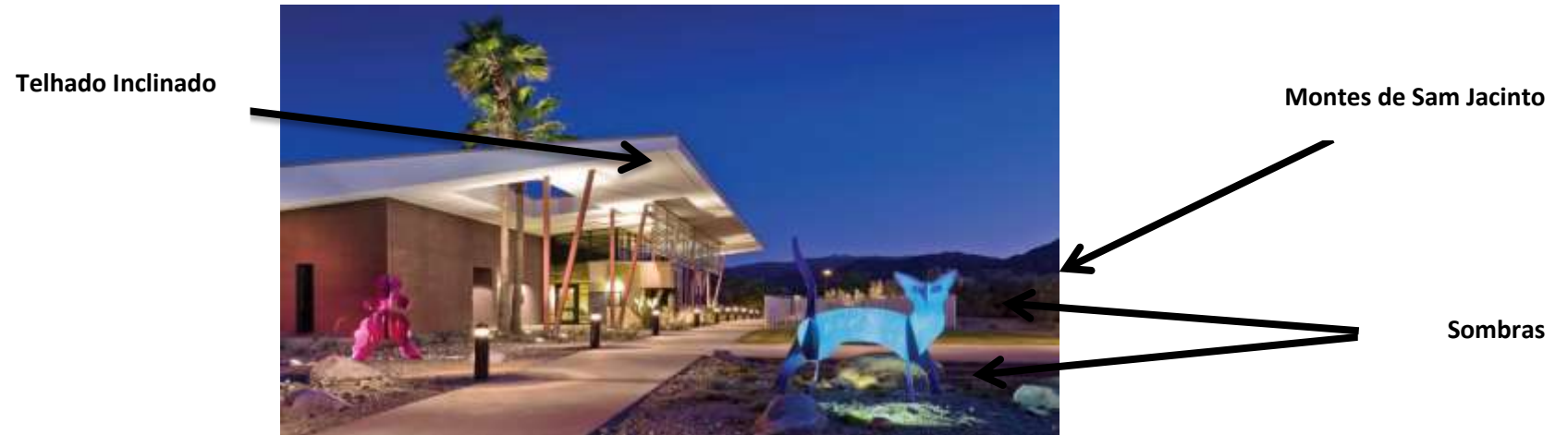
Figura 79 – Fachada com telhado elevado e de frente para os montes de Sam Jacinto
