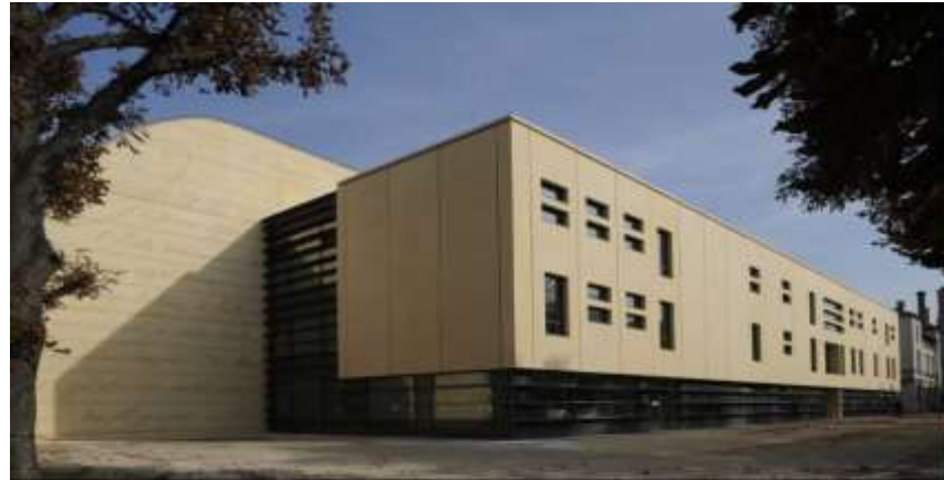
Figura 25 – Escola Veterinária de Alfort.
