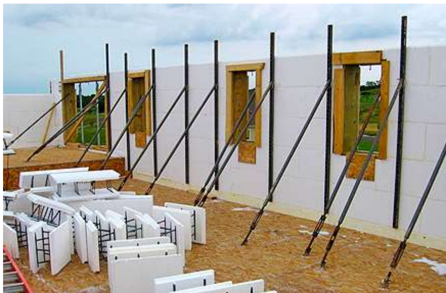
Figura 74: Construção com paredes ICF.
