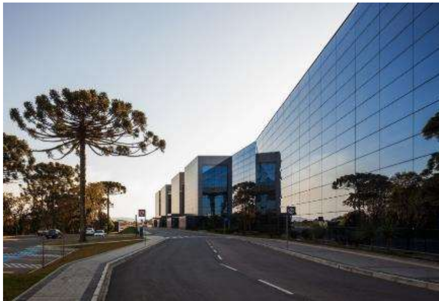
Figura 52: Fachada Hospital do Rocío
