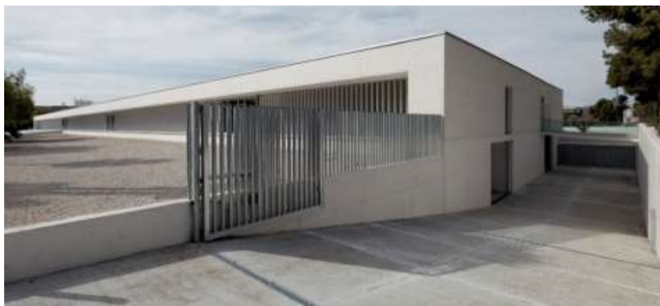
Figura 26 - Fachada lateral com acesso para área de serviço
