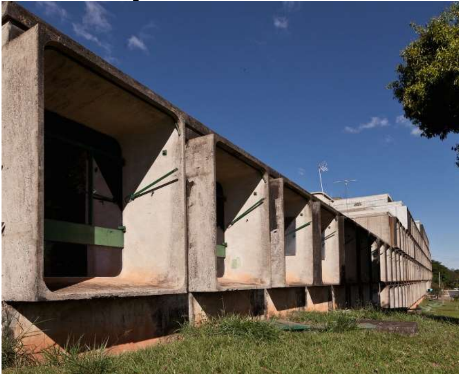
Figura 55 - Vista externa dos leitos
