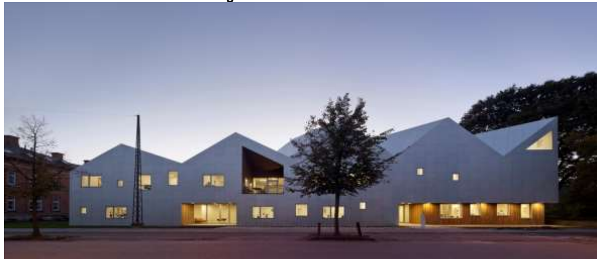
Figura 16 – Vista da fachada
