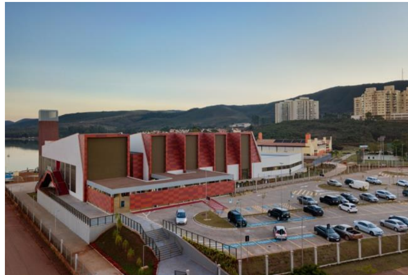
Figura 20 - Vista do edifício e estacionamento
