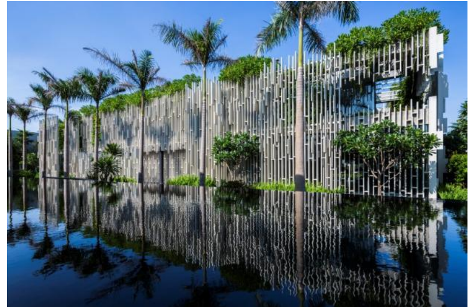
Figura 19: Espelho d'água na fachada- Spa Naman.
