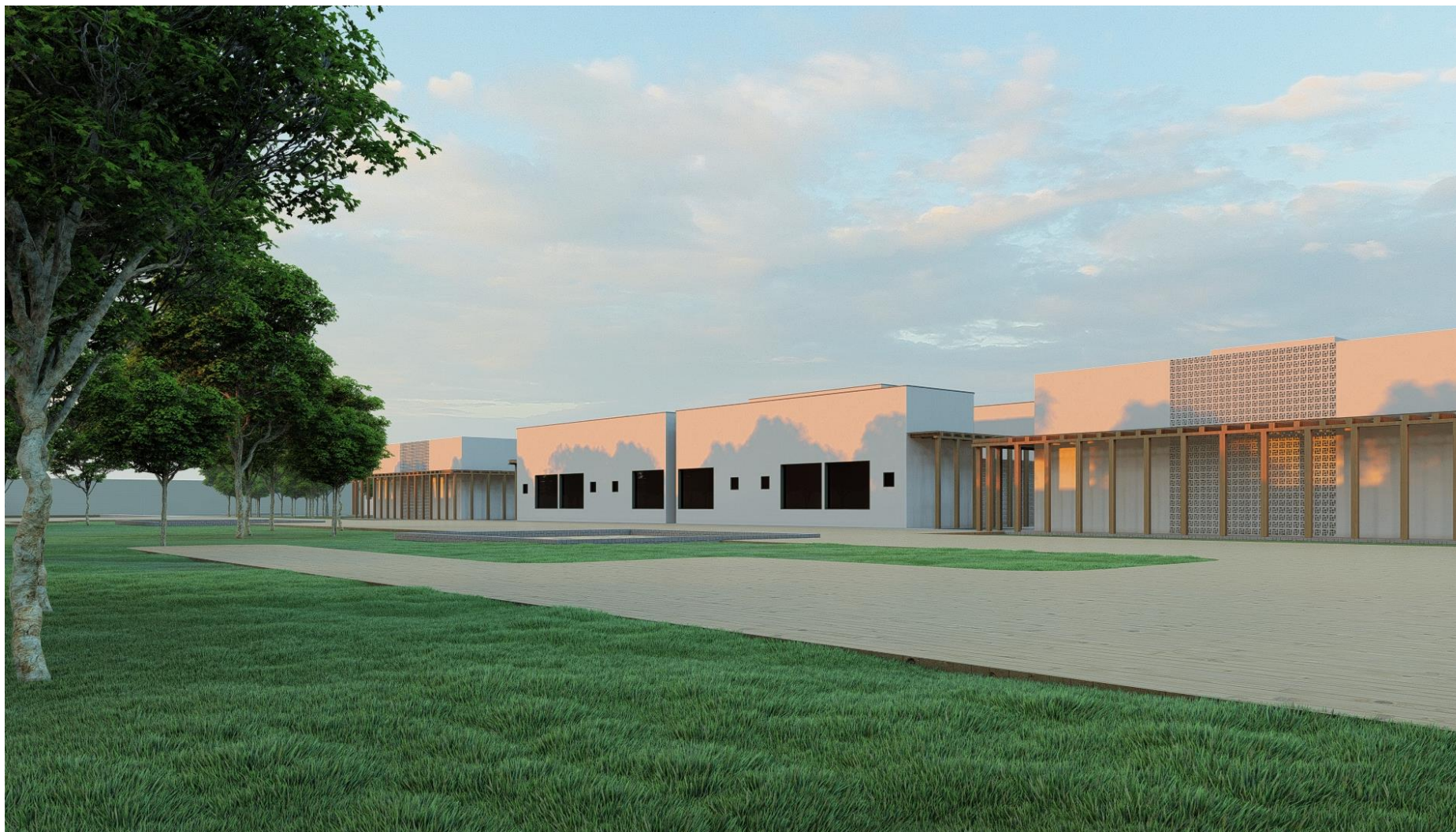
Figura 71: Área fundo da edificação.
