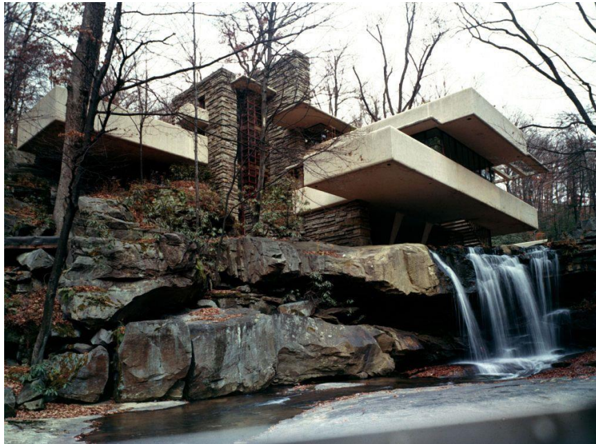
Figura 38: Base de rocha- Casa da Cascata.
