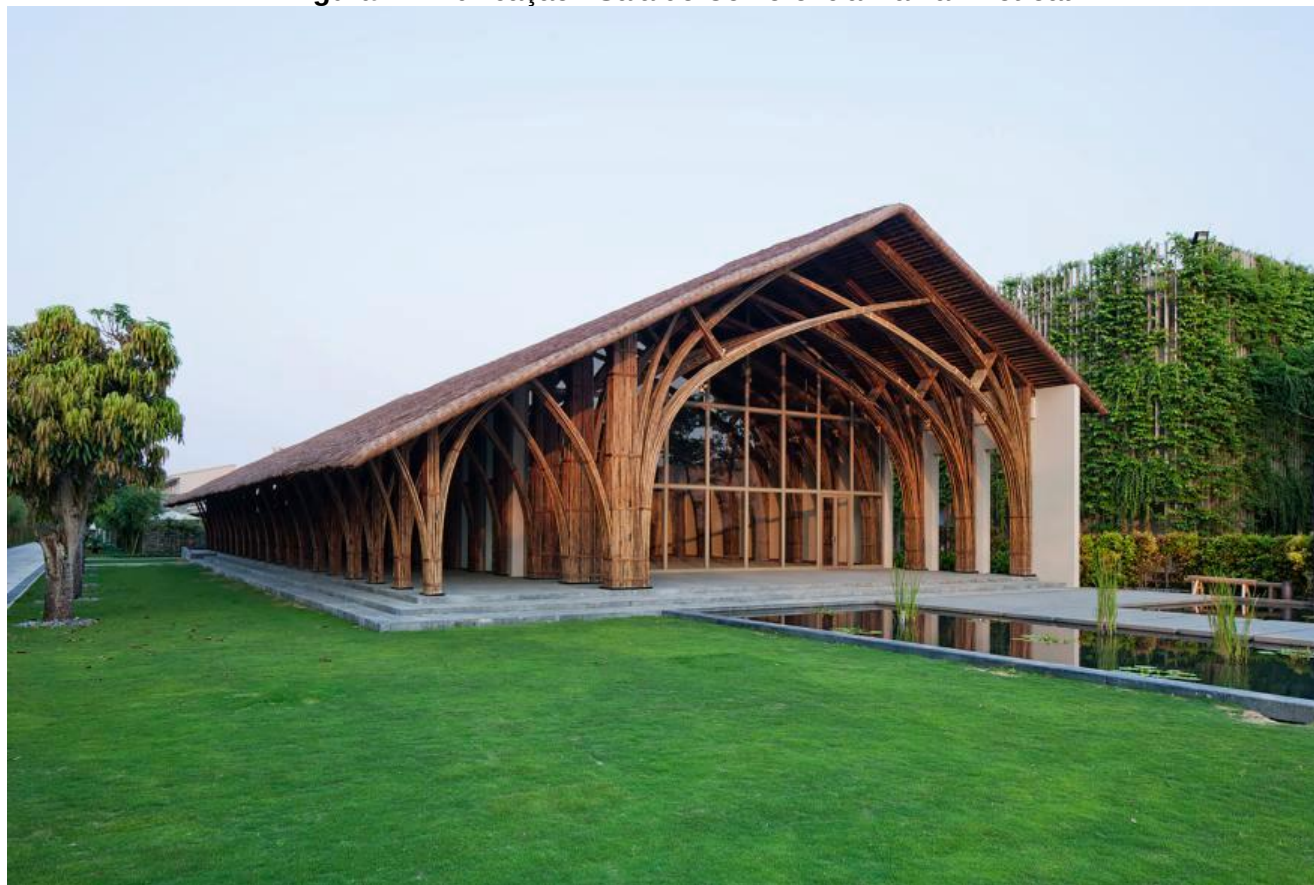
Figura 24: Edificação - Sala de Conferência-Naman Retreat
