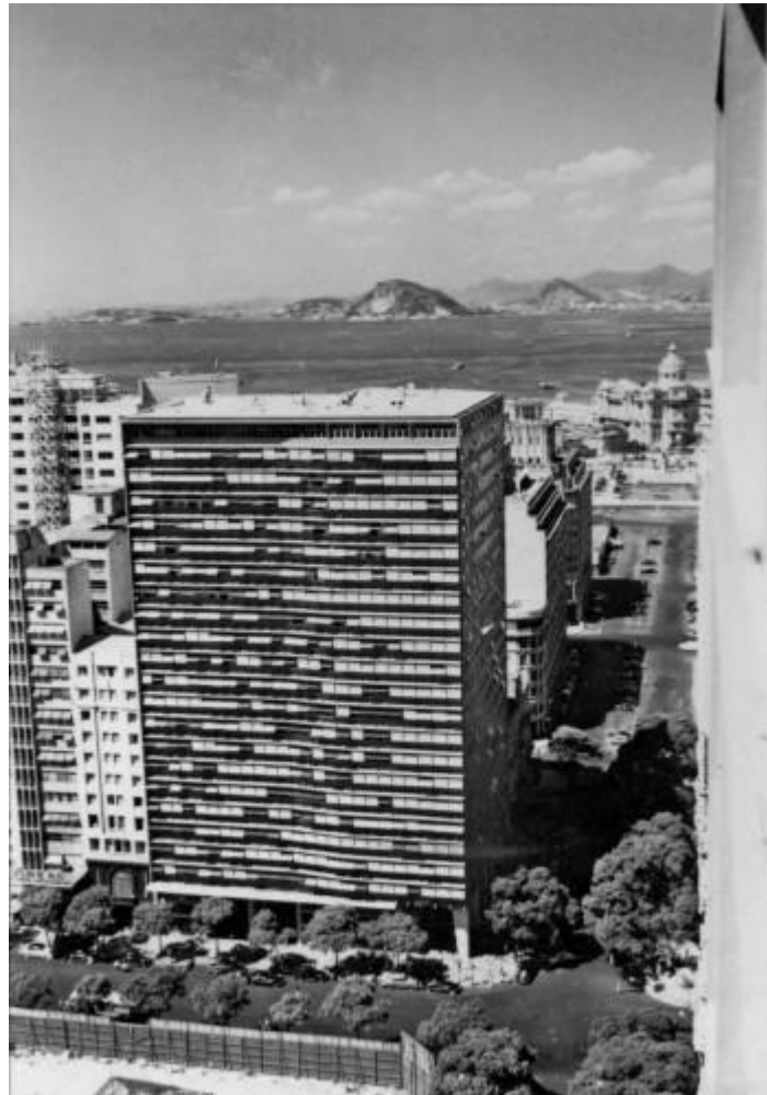
Imagem 14 – Edifício Marquês do Herval
