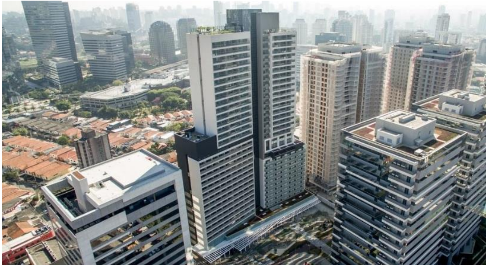
Imagem 35 – Vista aérea do Complexo Multiuso Praça São Paulo
