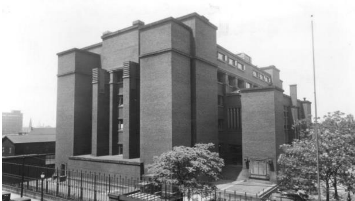
Imagem 06 – Fachada Larkin Building
