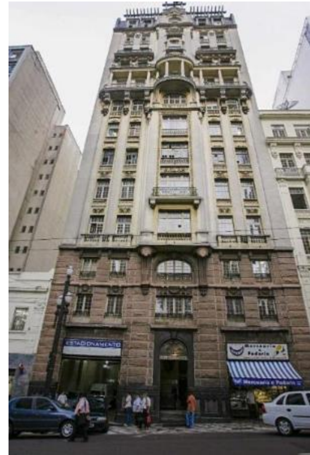
Imagem 04 – Edifício Sampaio Moreira
