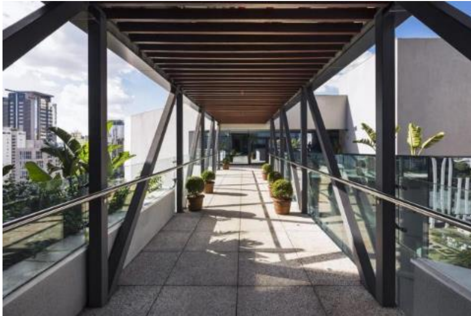
Imagem 23 – Passarela de ligação entre as duas edificações
