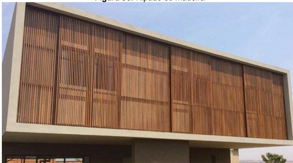
Figura 96: Ripado de madeira
