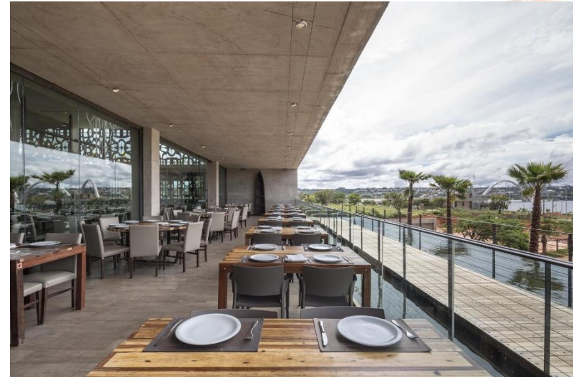
Figura 28: Passarela de madeira e aço
