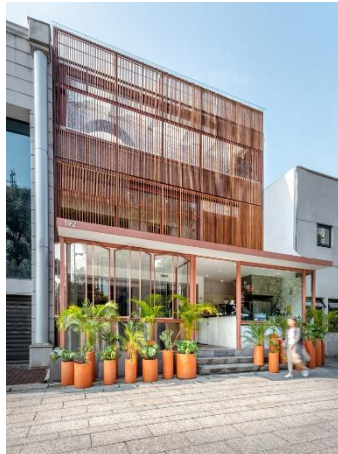
Figura 38: Fachada de madeira
