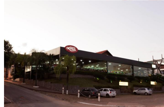
Figura 10: Pele de vidro na fachada
