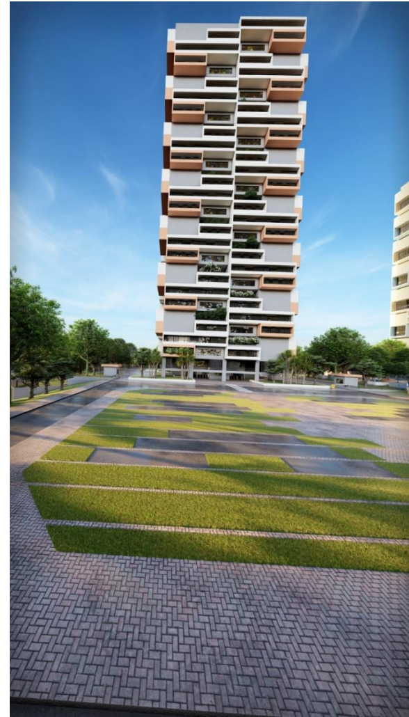
Figura 100 Acesso a Torre Pantanal Business
