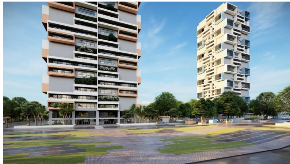
Figura 90 Vista das duas torres e área de convivência
