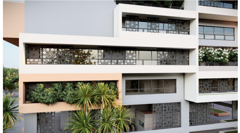
Figura 102 Detalhe das sacadas, Pantanal Business
