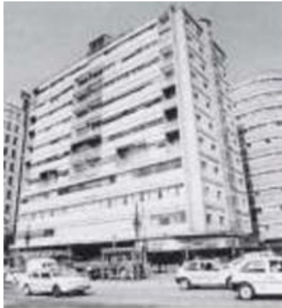
Figura 2 edifício comercial Esther
