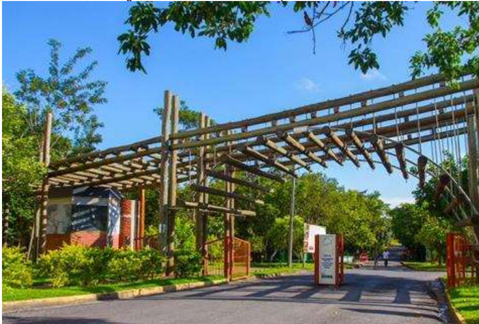
Figura 05: Pórtico de entrada Parque Mãe Bonifácia.
