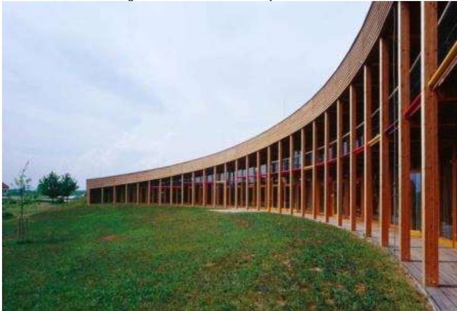
Figura 51: Fachada com utilização de madeira.
