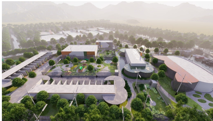
Figura 67 – Vista externa abrigo
