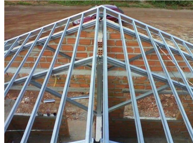
Figura 33 - Estrutura de Aço para cobertura.
