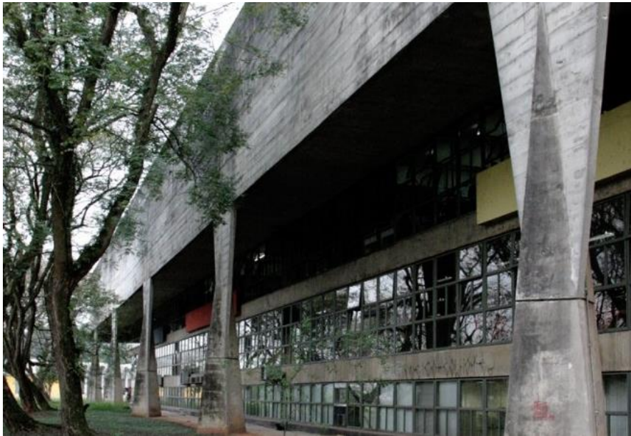
Figura 21 - Fachada com pilares da FAU-USP.
