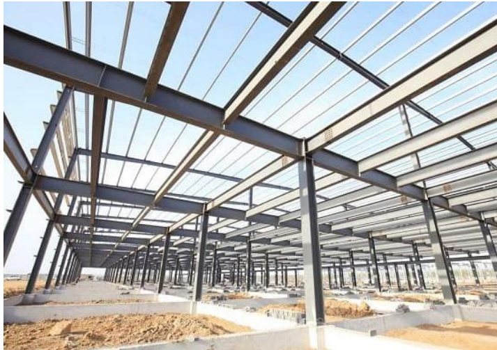
Figura 32 - Estrutura de aço.
