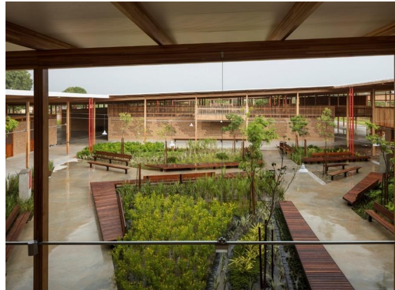
Figura 7 – Pátio central da Escola rural de Tocantins.
