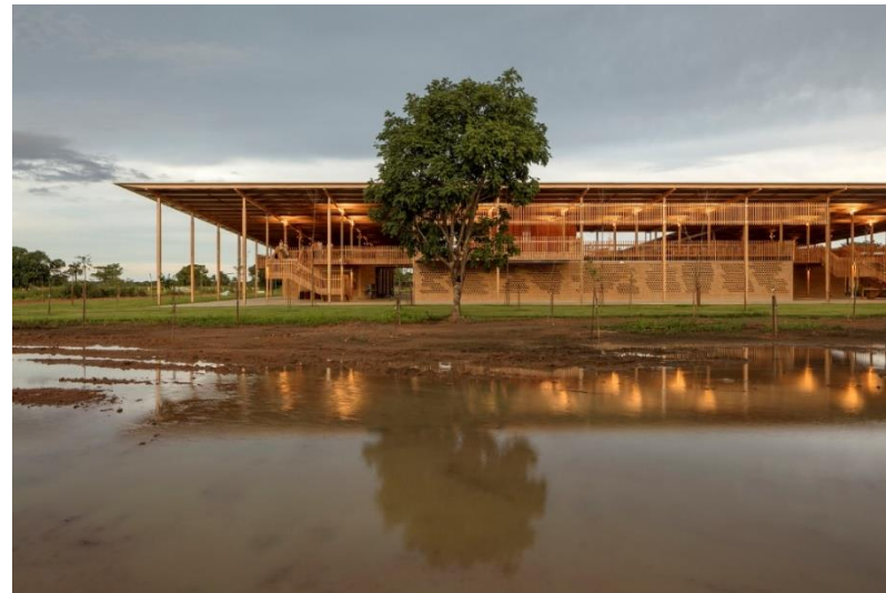
Figura 4 - Fachada lateral da Escola rural de Tocantins.
