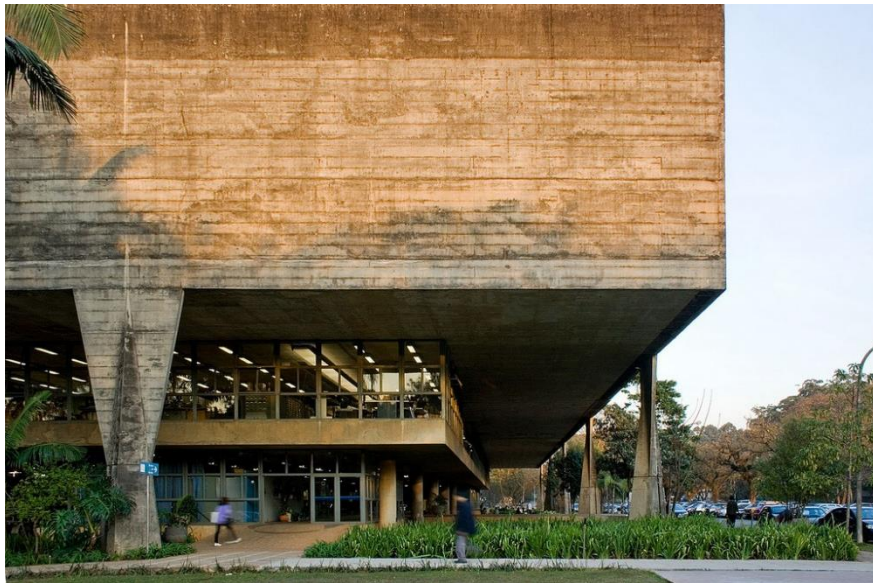
Figura 19 - Vista da fachada lateral da FAU-USP.
