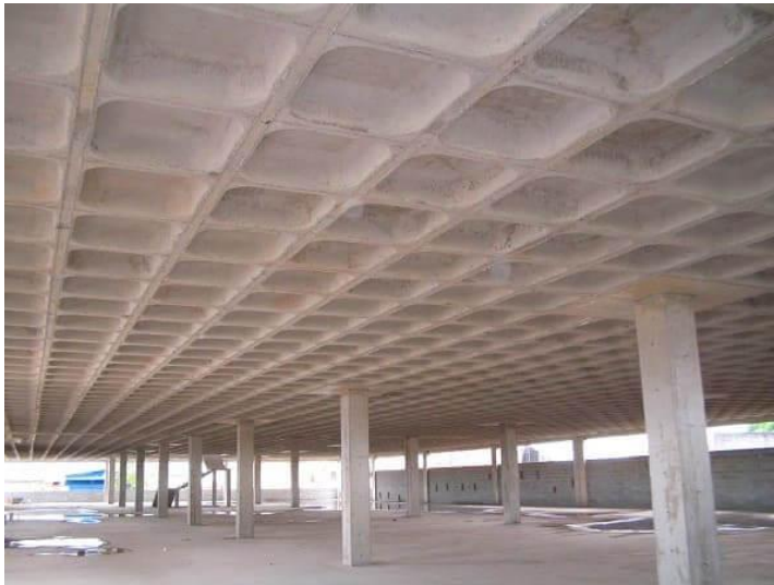
Figura 35 - Estrutura de laje nervurada.
