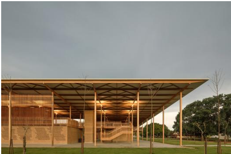
Figura 5 - Fachada da Escola rural de Tocantins.
