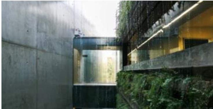
Figura 24 interior 03 Centro cultural Porto Seguro
