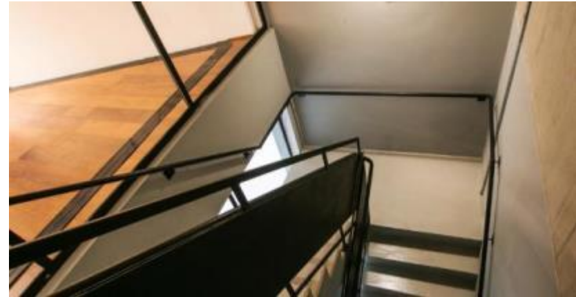
Figura 23 interior 02 Centro cultural Porto Seguro
