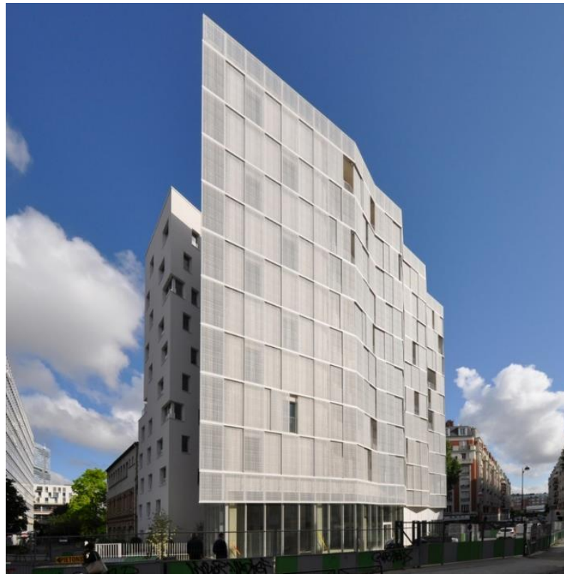
Figura 38: Fachada habitação social em Paris
