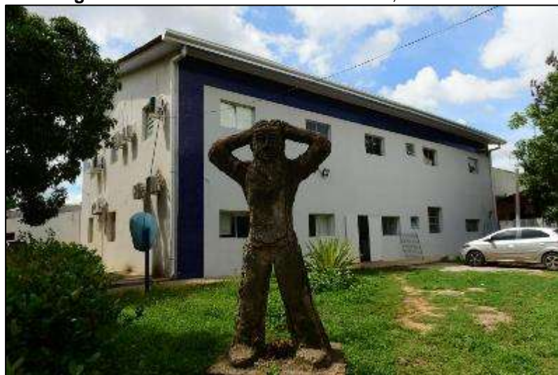
Figura 21 – Fachada do Adauto Botelho, Cuiabá – MT
