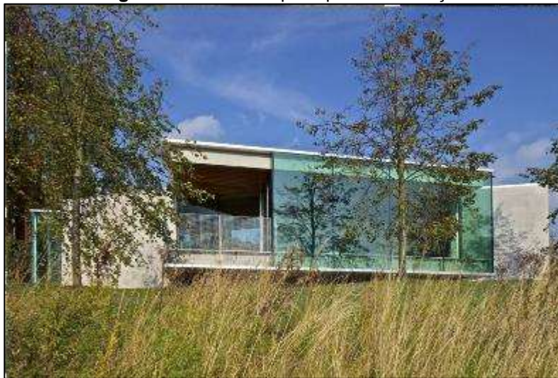
Figura 43 - Fachada principal da edificação
