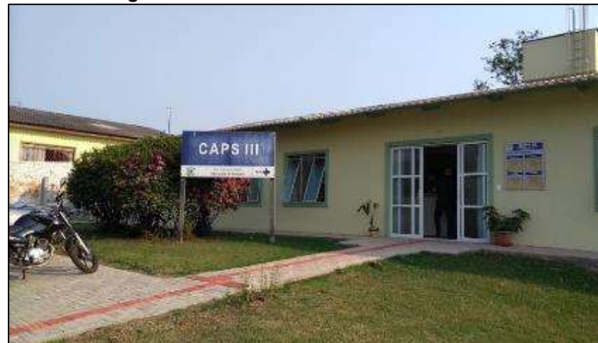
Figura 26 – Fachada do CAPS III Cuiabá – MT
