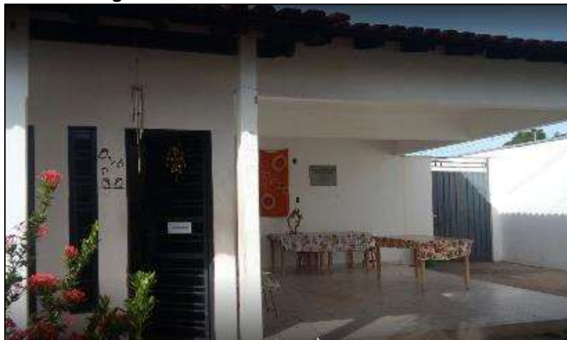
Figura 25 – Fachada do CAPS II Cuiabá – MT
