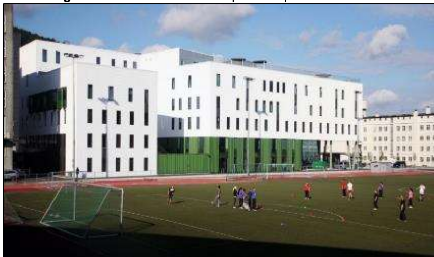
Figura 13 – Área externa Hospital Psiquiátrico Kronstad
