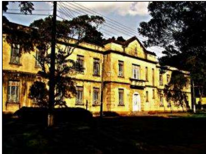
Figura 05 – Hospital psiquiátrico Juqueri, em São Paulo - Fachada
