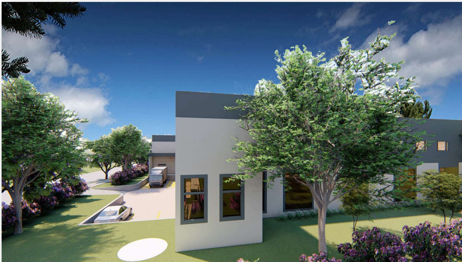
Figura 81 - Cisterna no fundo da edificação no subsolo
