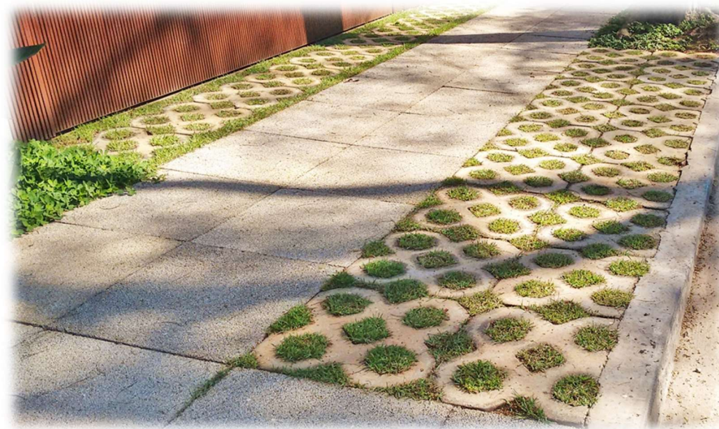
Figura 5 - Piso drenante aplicado
