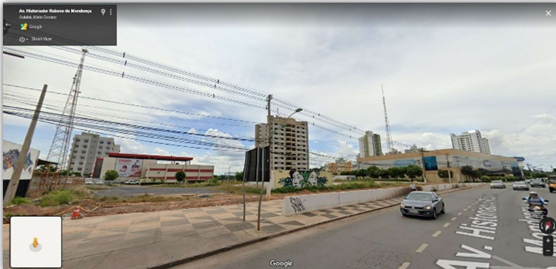
Figura 67 Terreno frente para a av. Rubens de Mendonça- vista frontal vindo do centro da cidade
