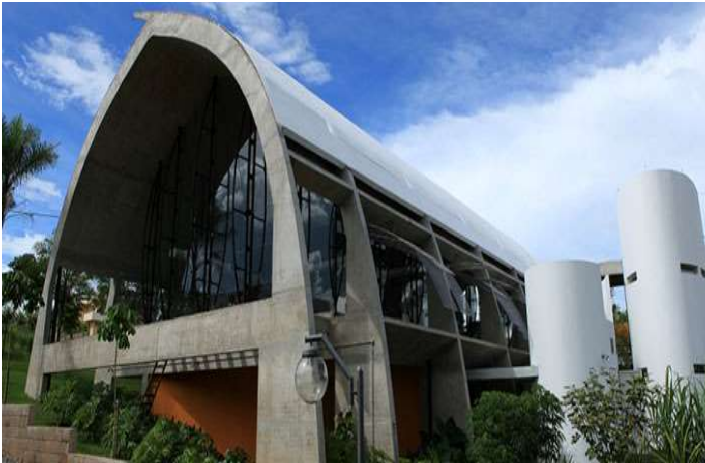
Figura 38 -- Centro Sebrae de sustentabilidade fachada
