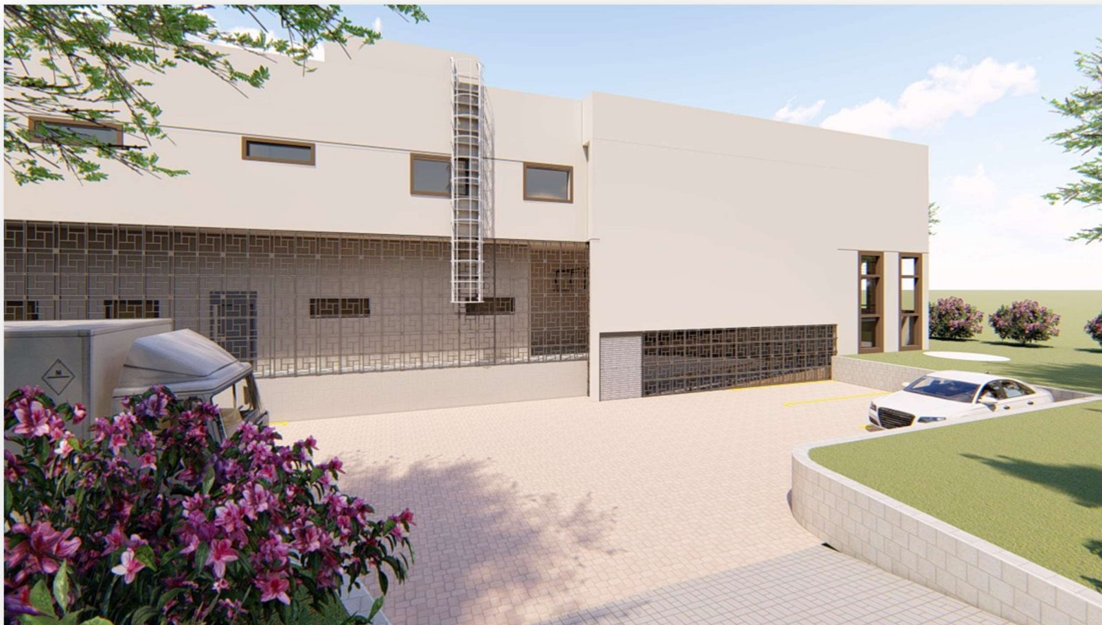
Figura 98- Desnível criado para a plataforma da doca
