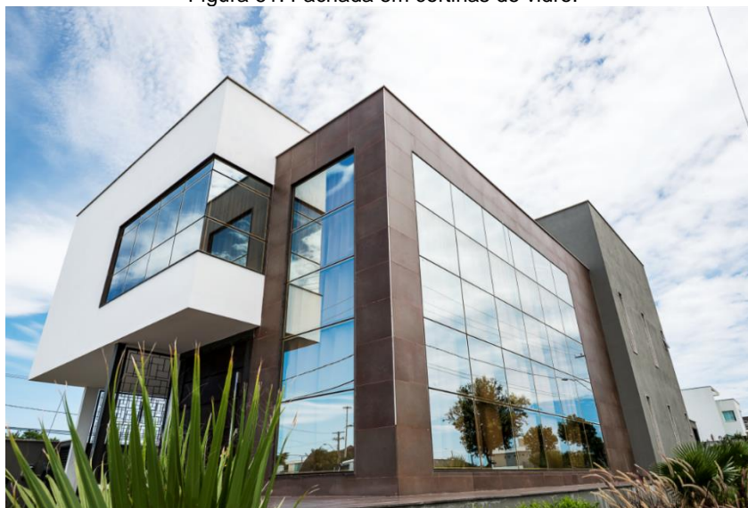
Figura 61: Fachada em cortinas de vidro.
