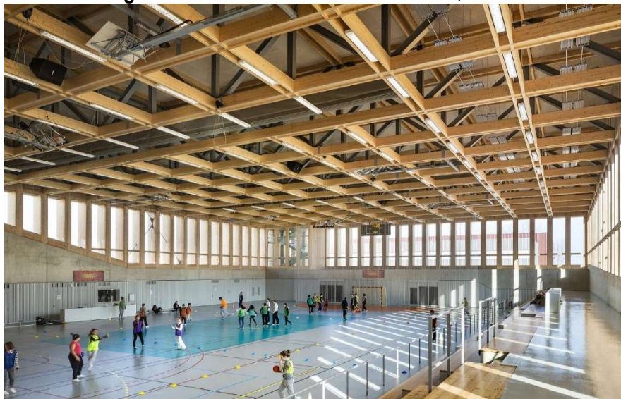
Figura 28: Detalhes do Madeiramento Quadra
