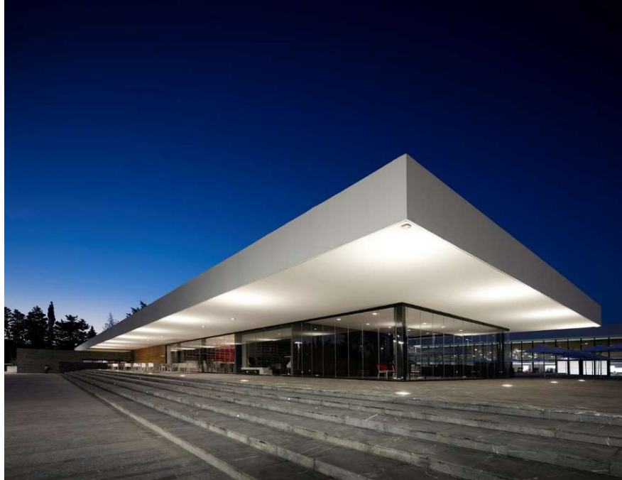
Figura 12: Fachada - Detalhe da Cobertura
