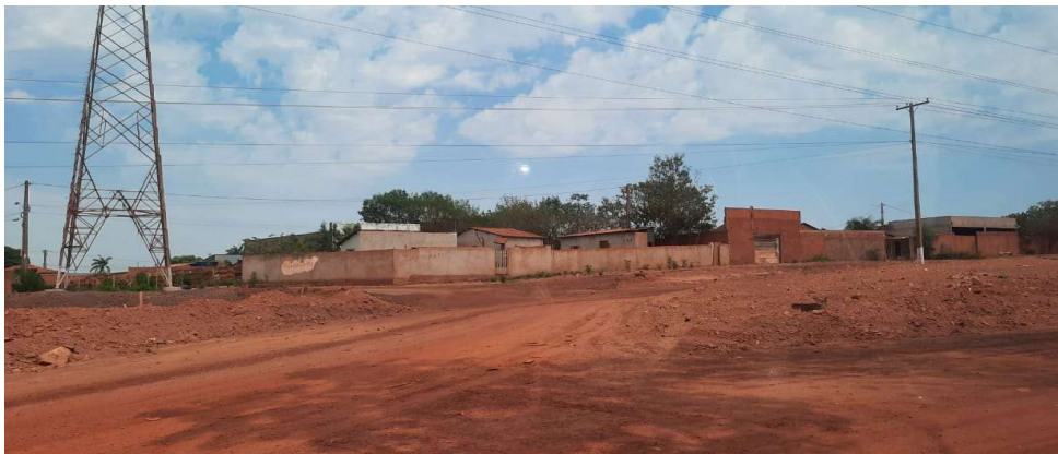
Figura 77: Torres de Transmissão 01
