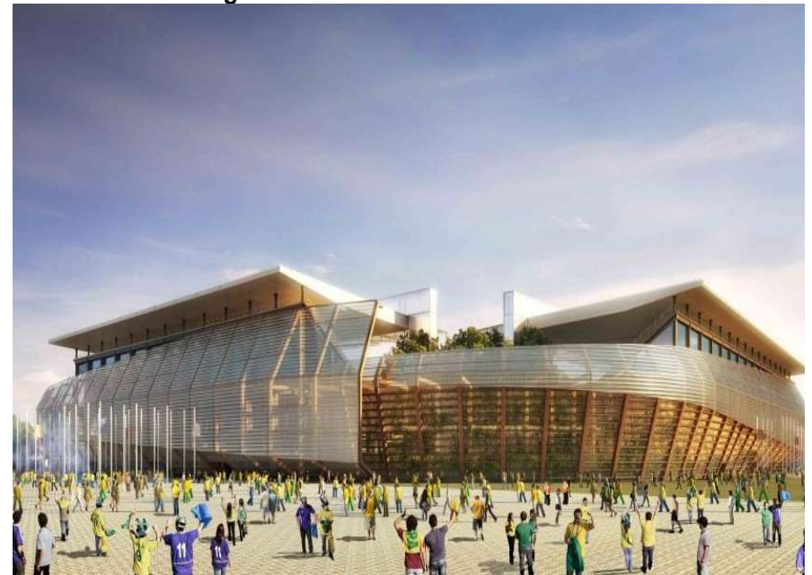
Figura 37: Fachada Arena Pantanal
