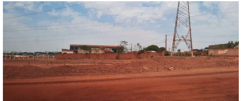
Figura 78: Torres de Transmissão 02
