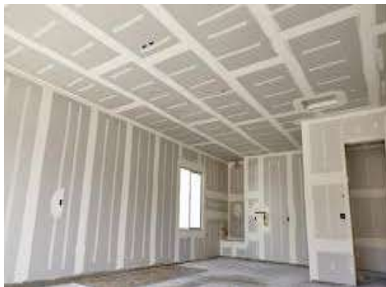
Figura 6: Parede em Drywall
