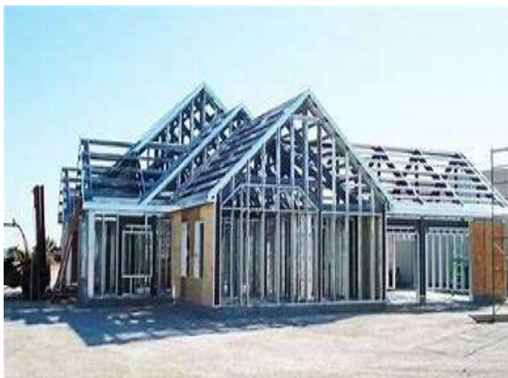
Figura 7: Casas construídas em Steel Frame
