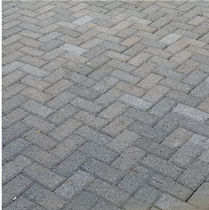
Figura 35 – Calçada com Tijolinhos Drenantes Fonte: Google (2021)
