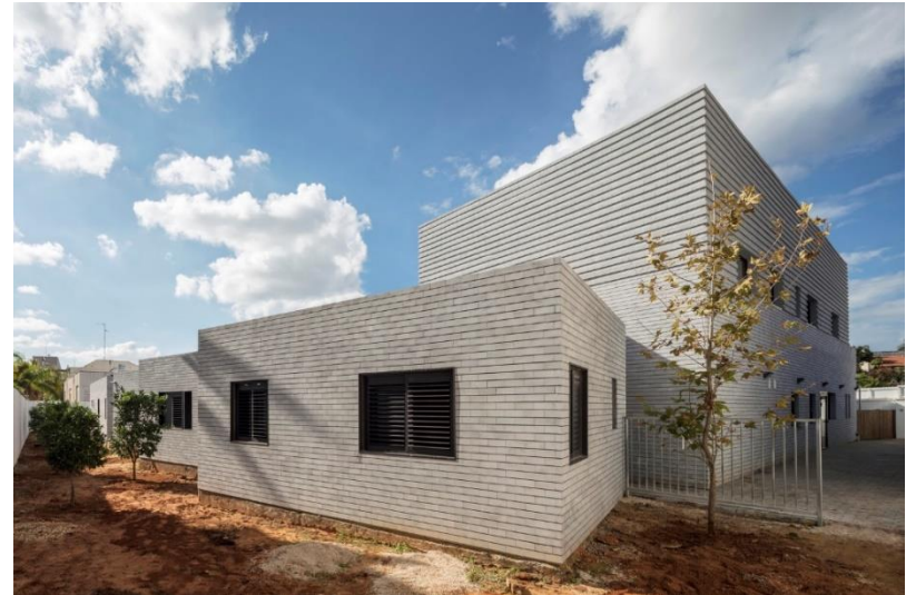
Figura 13: Fachada da Edificação
