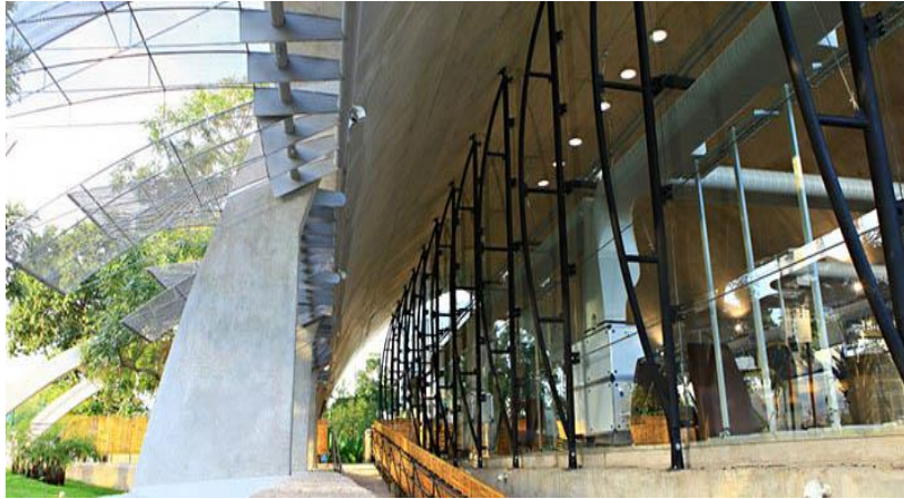
Figura 36: Paredes de Vidro
