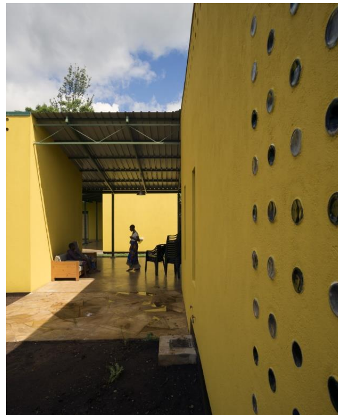
Figura 10: Parede externa do banheiro
