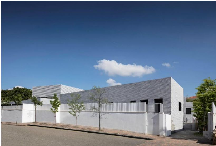
Figura 12: Entrada da Edificação
