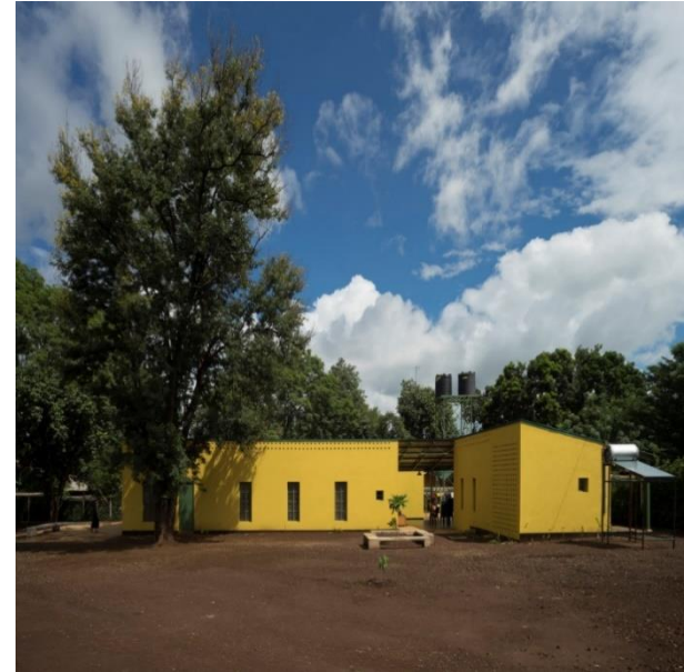
Figura 6: Fachada da edificação
