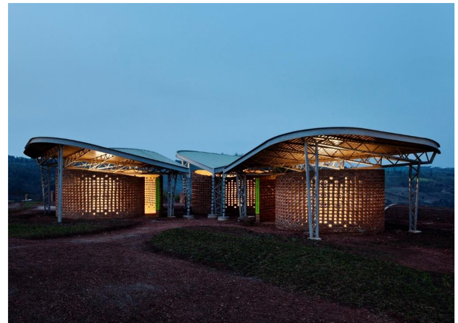
Figura 18: Salas de Aulas
