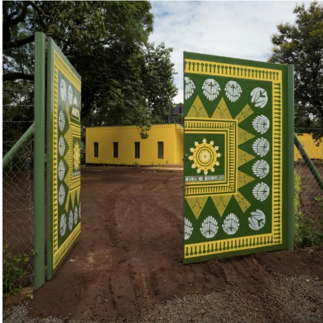
Figura 5: Portão de Entrada da Edificação
