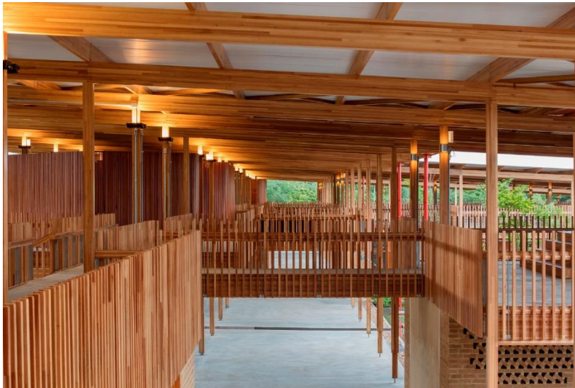
Figura 29: Estrutura de madeira
