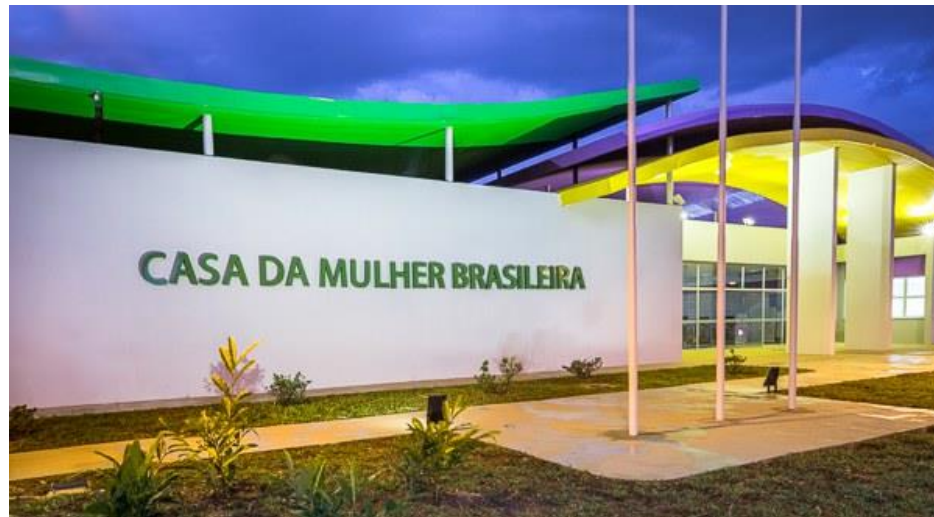
Figura 22: Fachada da Edificação
