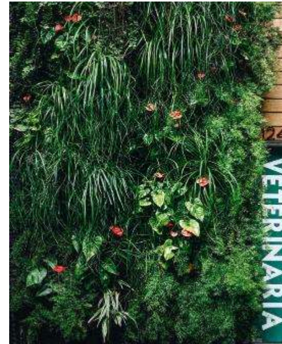
Figura 15: Detalhes da fachada viva da clínica veterinária.
