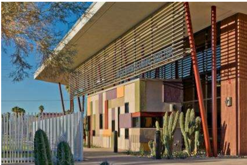
Figura 35: Fachada do abrigo.
