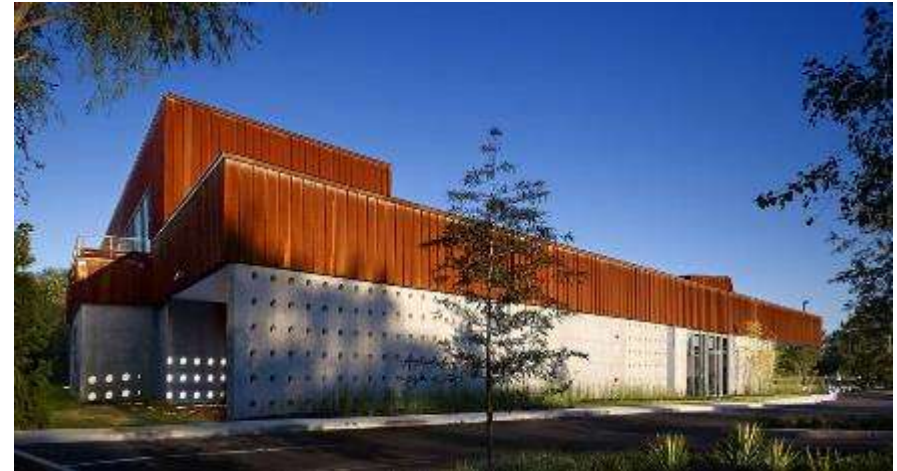
Figura 45: Fachada lateral e posterior da edificação.
