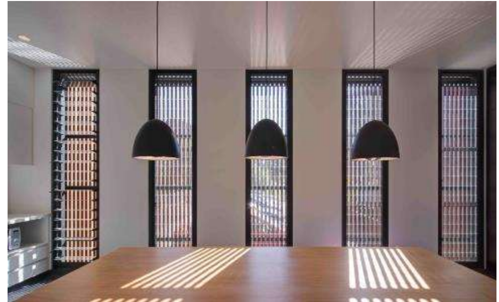
Figura 50: Efeito dos brises amadeirados de proteção solar.
