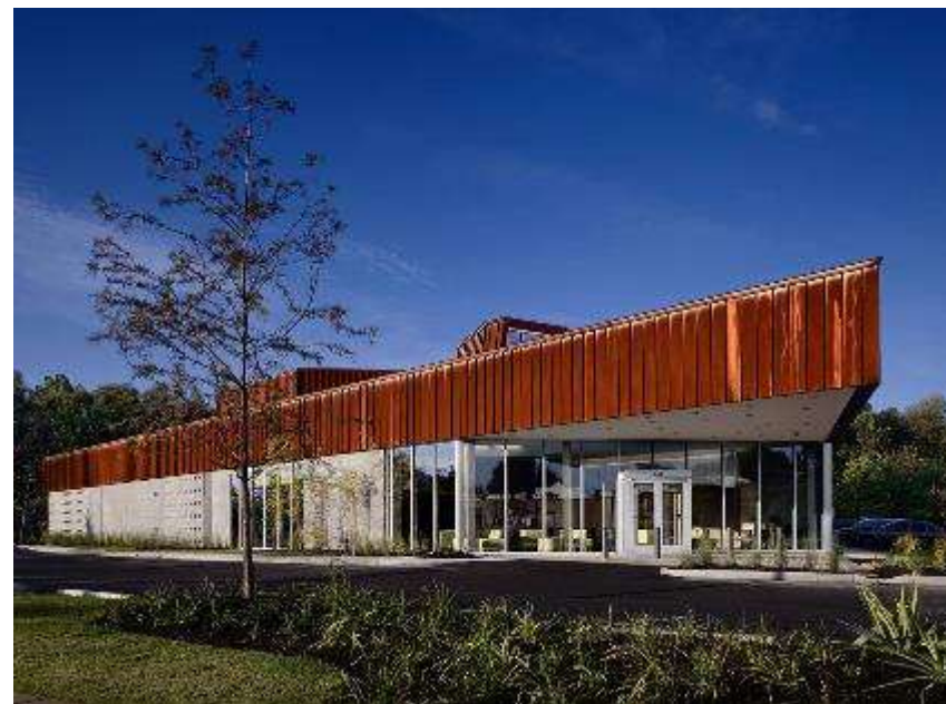
Figura 39 Fachada lateral esquerda da edificação.
