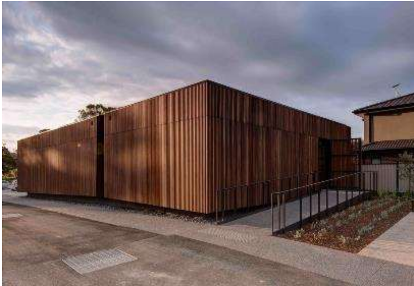
Figura 47: Fachada lateral e acesso principal à edificação.
