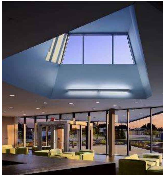
Figura 40: Detalhe entrada de iluminação natural.
