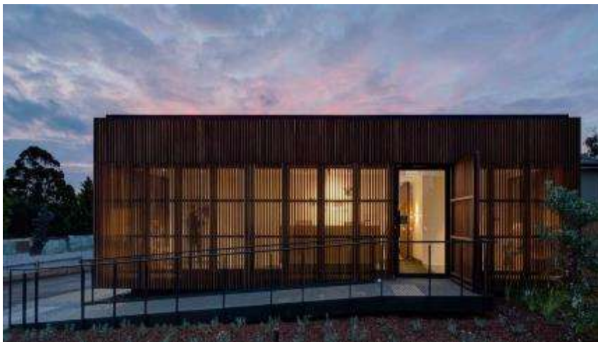
Figura 51: Fachada principal da clínica veterinária.
