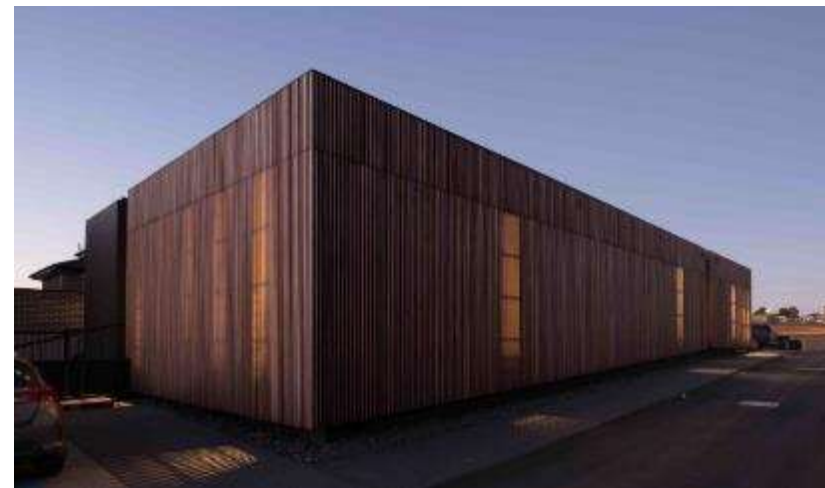
Figura 52: Fachada posterior da edificação.
