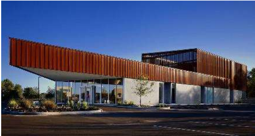
Figura 44: Fachada lateral direita da edificação.
