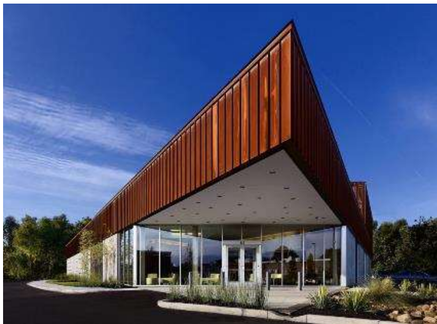
Figura 38: Fachada e acesso principal da edificação.
