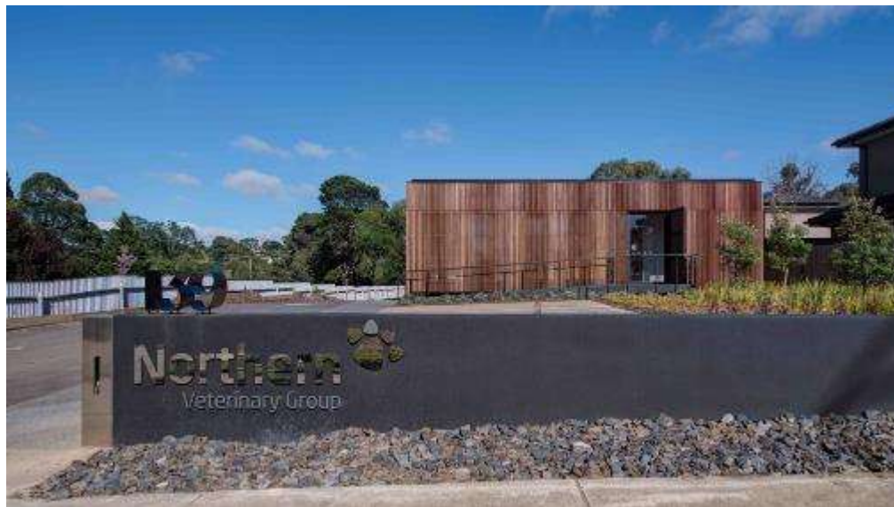
Figura 46: Fachada e acesso principal da edificação.
