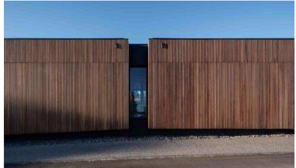
Figura 48: Fachada lateral direita da edificação.
