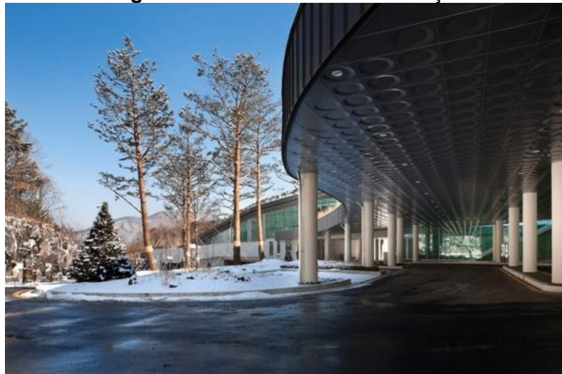
Figura 46: Vista externa da edificação
