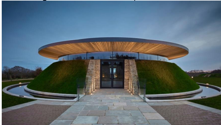
Figura 20: Fachada da capela/crematório
