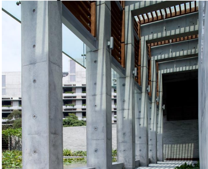
Figura 18: Corredor do edifício
