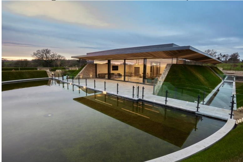
Figura 23: Vista externa da edificação
