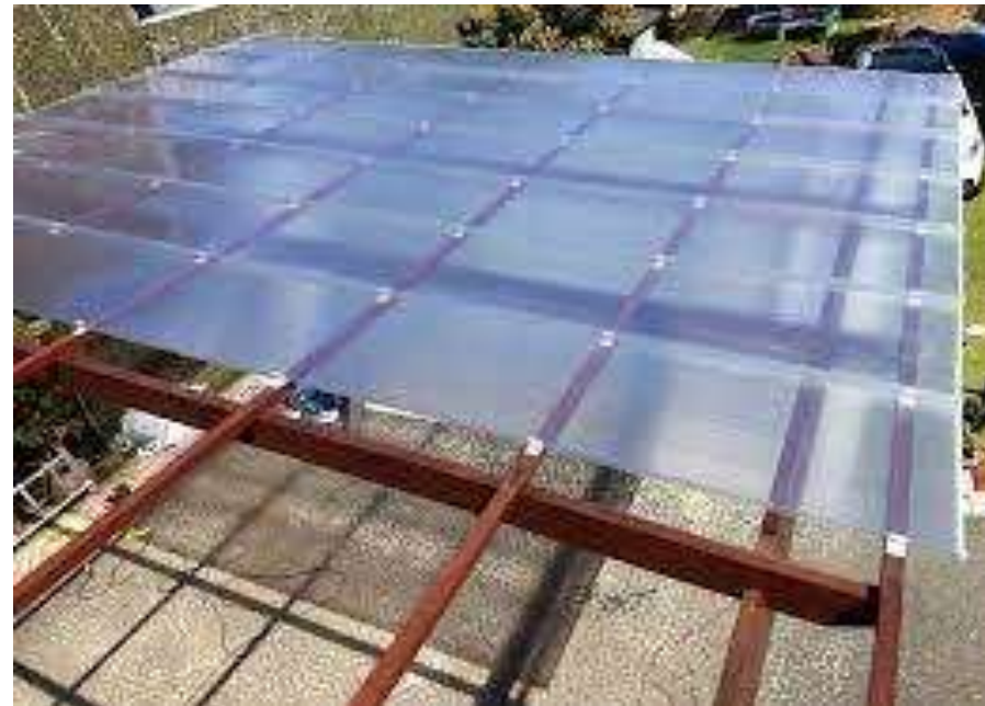
Figura 98 – Representação Telha Polícarbonato e Estrutura
