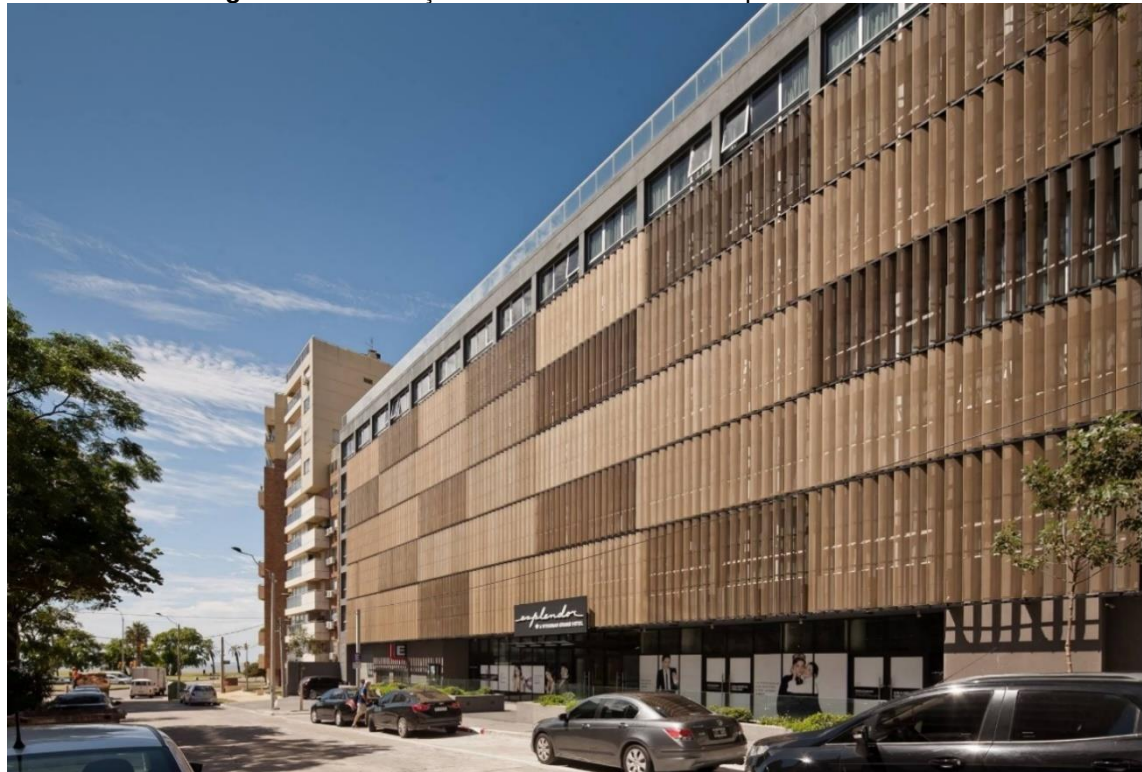
Figura 73 – Utilização vertical do Aeroscreen plano em fachada.
