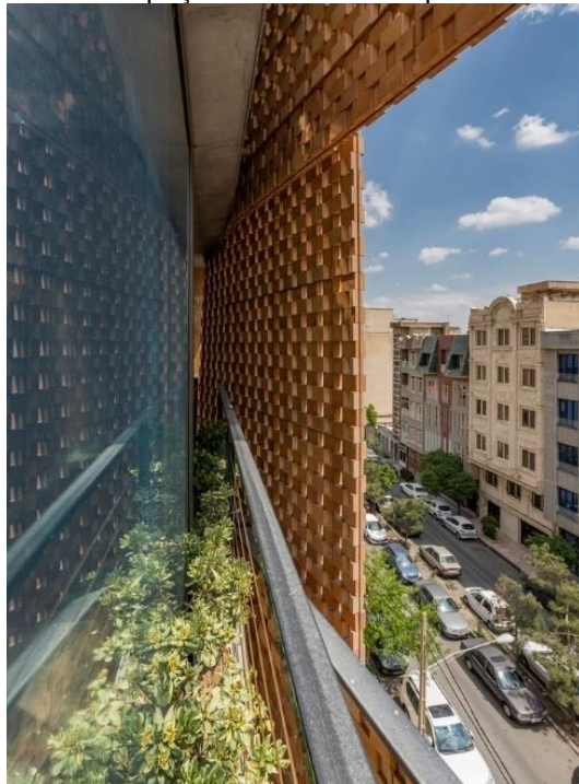
Figura 29 – Espaçamento das duas peles do edifício.
