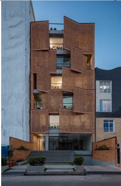
Figura 27 – Fachada em trama de tijolos.
