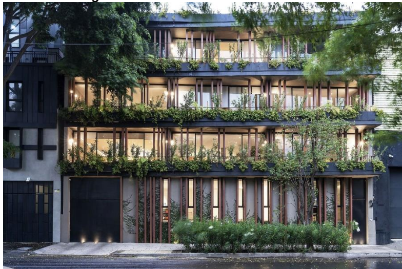
Figura 21 – Fachada do Edifício Cova07.
