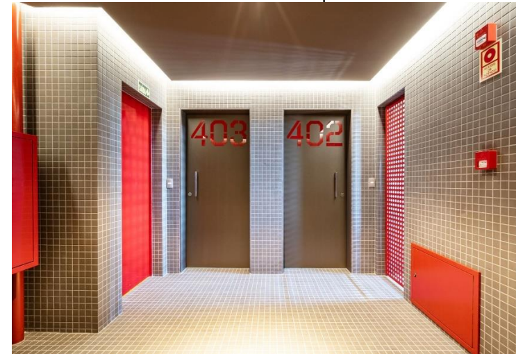
Figura 43 – Hall de circulação dos pavimentos com revestimento cerâmico em todas as paredes.
