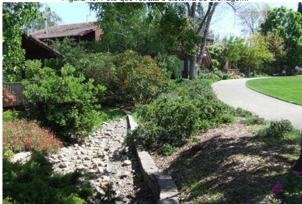
Figura 49: Foto que retrata o sistema de drenagem.
