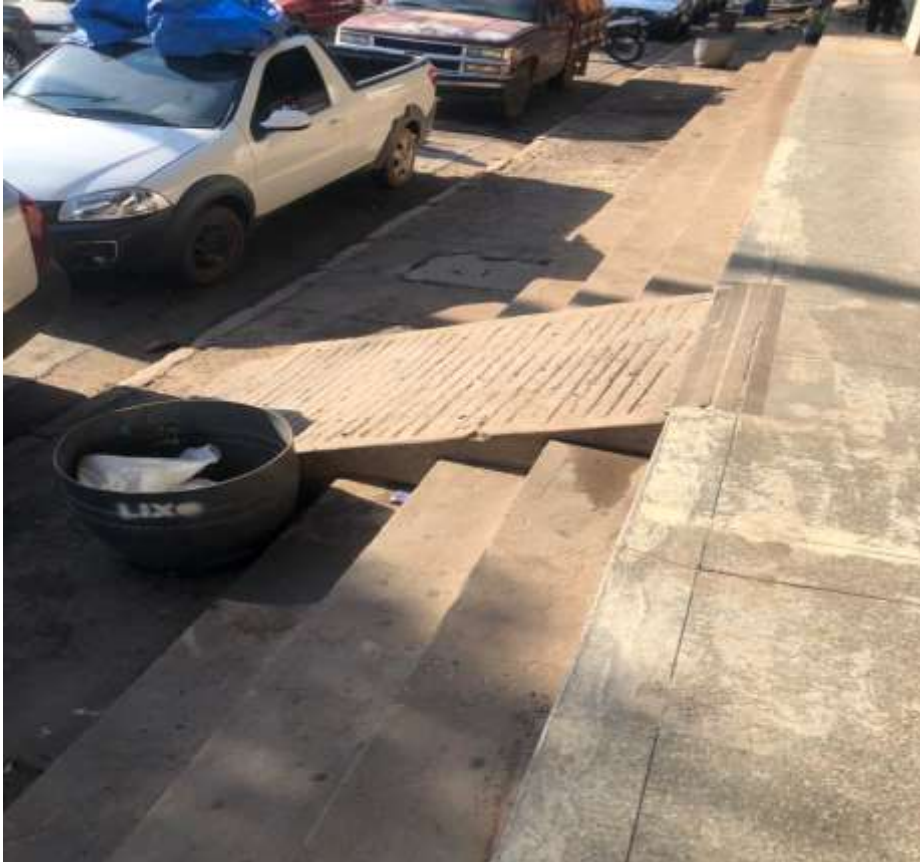
Figura 17 - Rampa de Acesso
