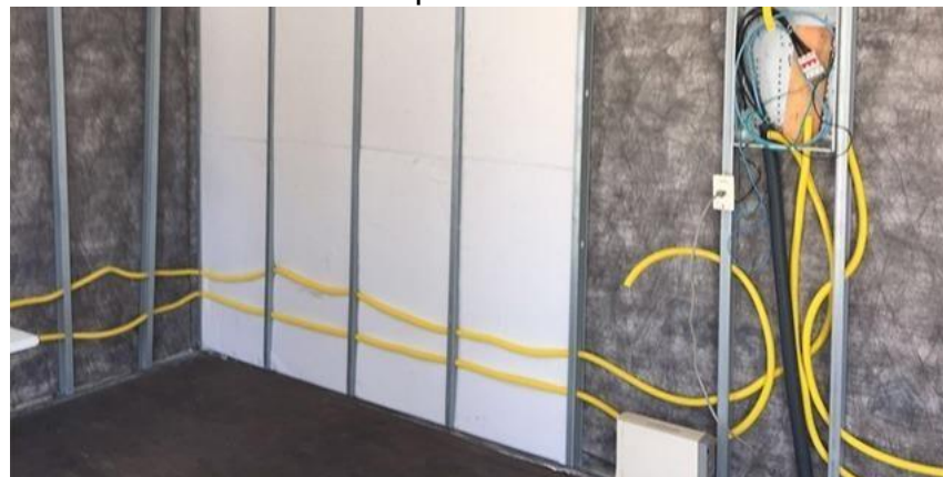
FIGURA 83 – Lã de pet wall trisoft em contêiner
