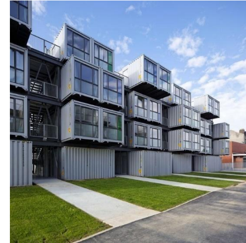
Figura 36: Aberturas para entrada de iluminação e Ventilação.
