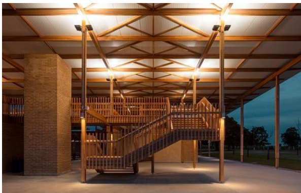
Figura 58: Acesso ao pavimento superior.
