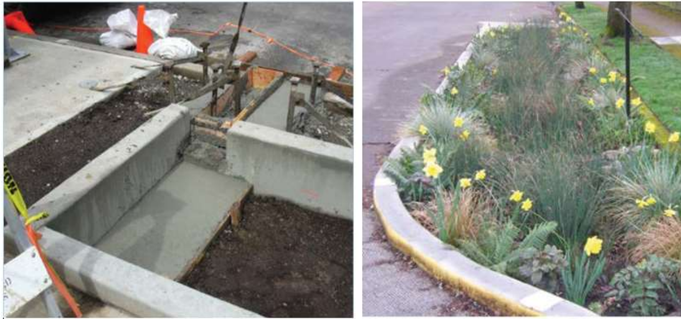
Figura 3 - execução de jardim de chuva
