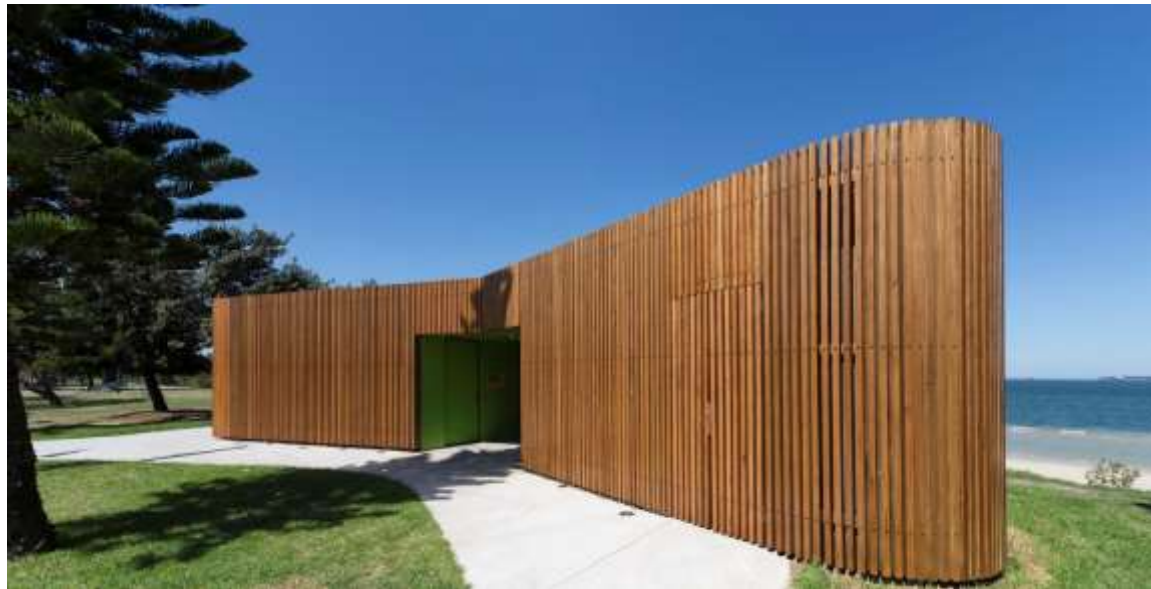
Figura 20 - Banheiro público do parque Cook
