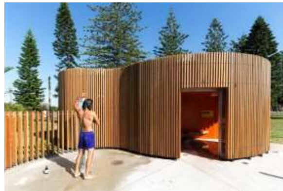
Figura 22 - Primeiro bloco de banheiro.
